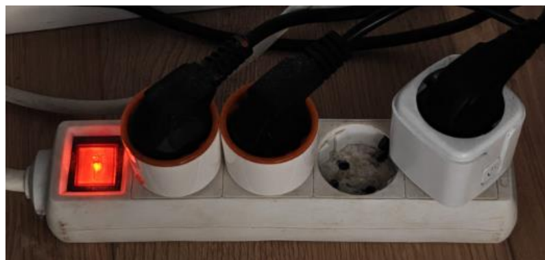
Figura 3.17. Medidor consumo eléctrico
