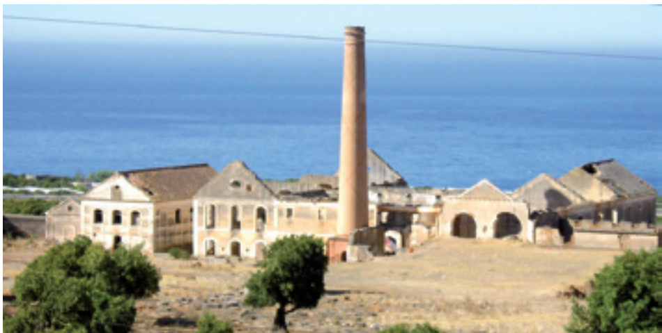
Patrimonio industrial. Antigua fábrica de azúcar en Maro
