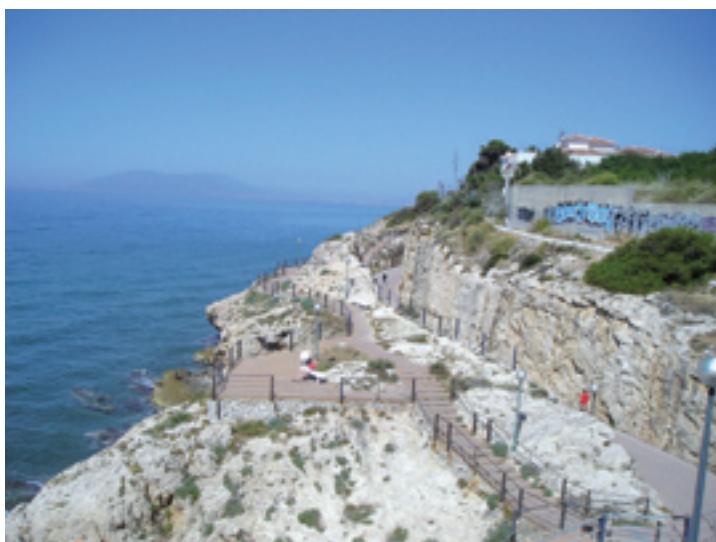
Alteración del acantilado
