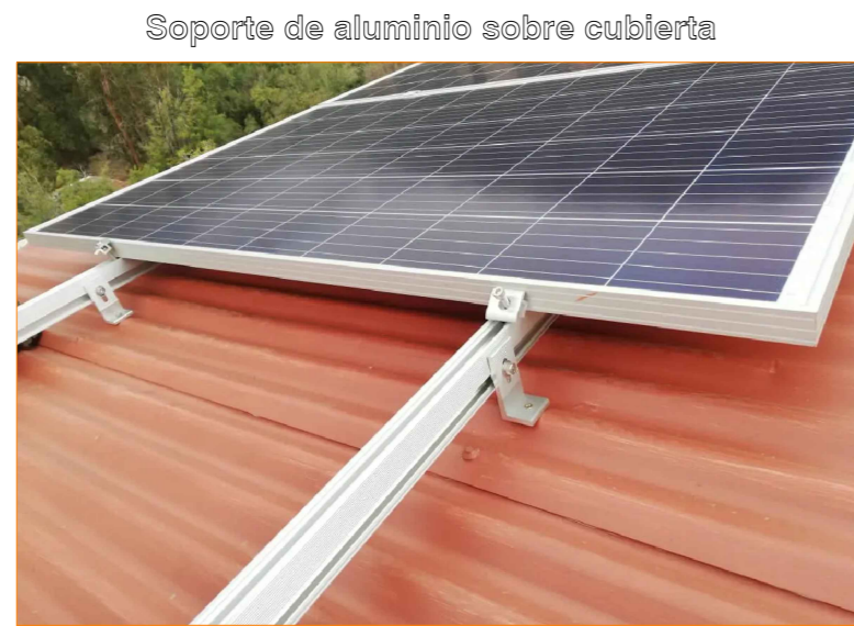
DETALLE ELEMENTOS DE UNIÓN DE LA ESTRUCTURA DE ALUMINIO
