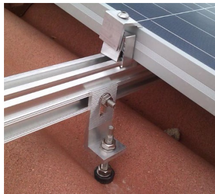
Figura 11: Unión cubierta-estructura del panel (Fuente: Elaboración propia)
