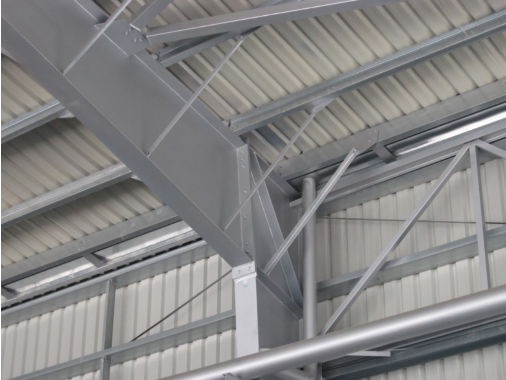
Figura 14: “Tornapunta. Imagen Nave Industrial. Fuente: www.medifestructuras.com ”
