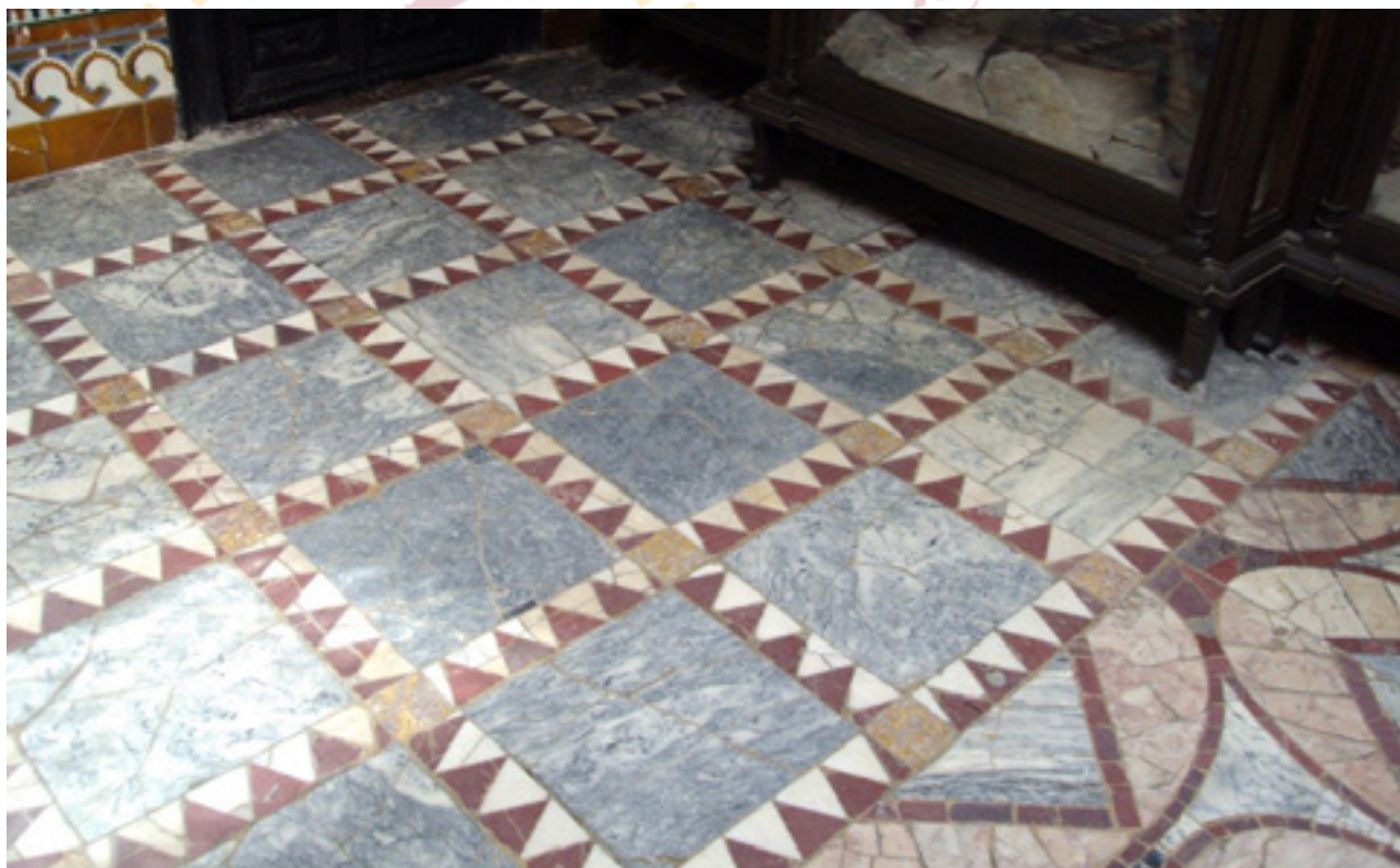
Figura 7. Opus sectile de uno de los ángulos de la galería del patio principal, de la Casa Palacio de la Condesa de Lebrija, Sevilla.
