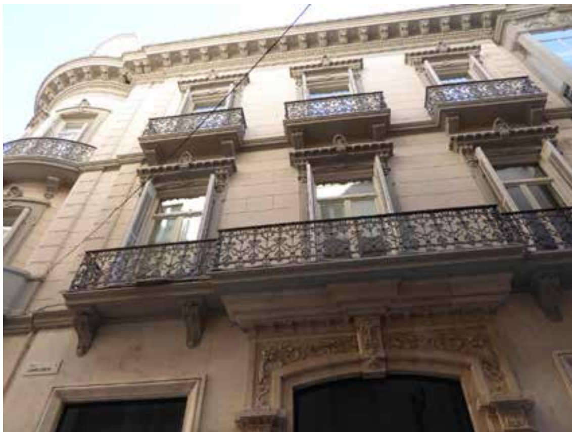
Fachada a calle Liborio García
