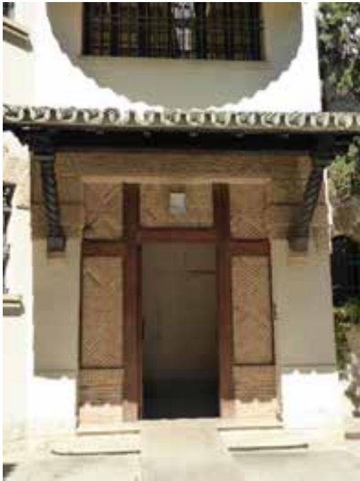
Paramento con "imprentones"
