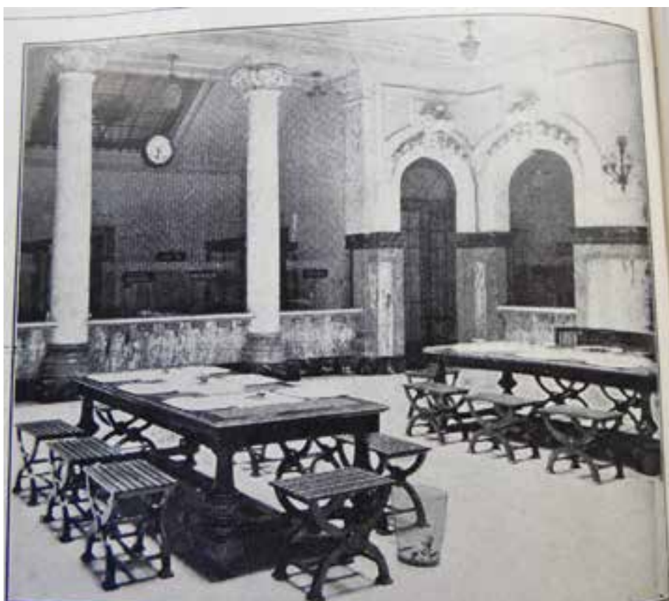
Patio de operaciones
