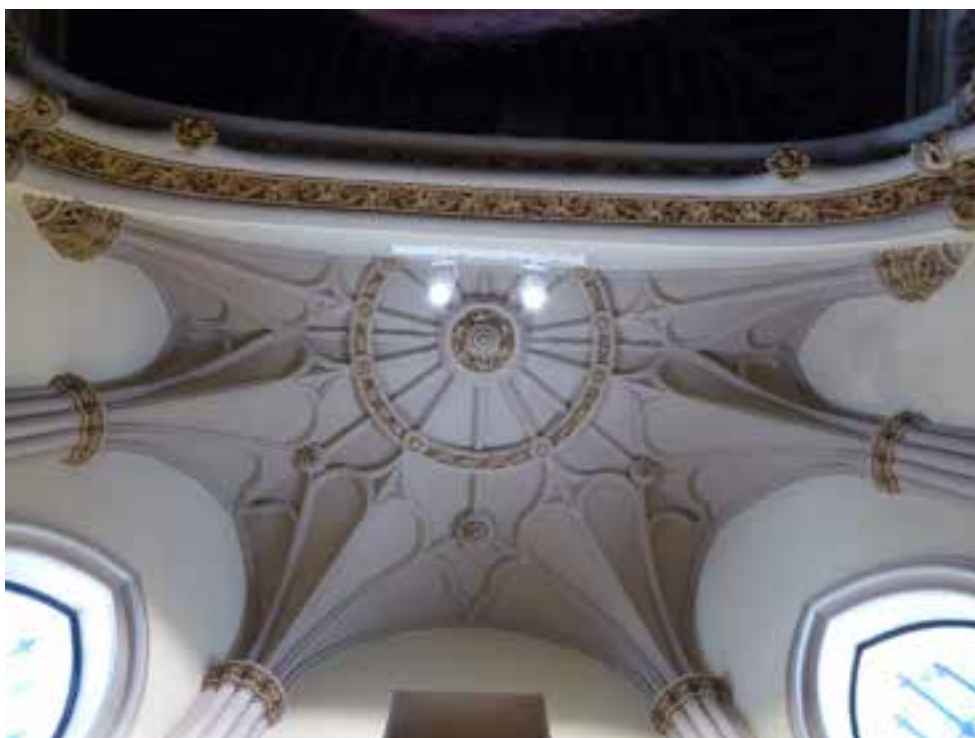
Bóveda del presbiterio
