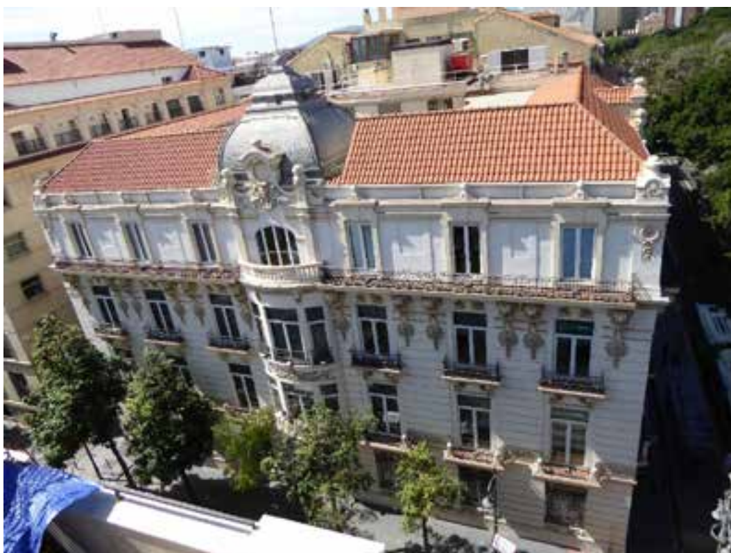
Fachada a calle Córdoba
