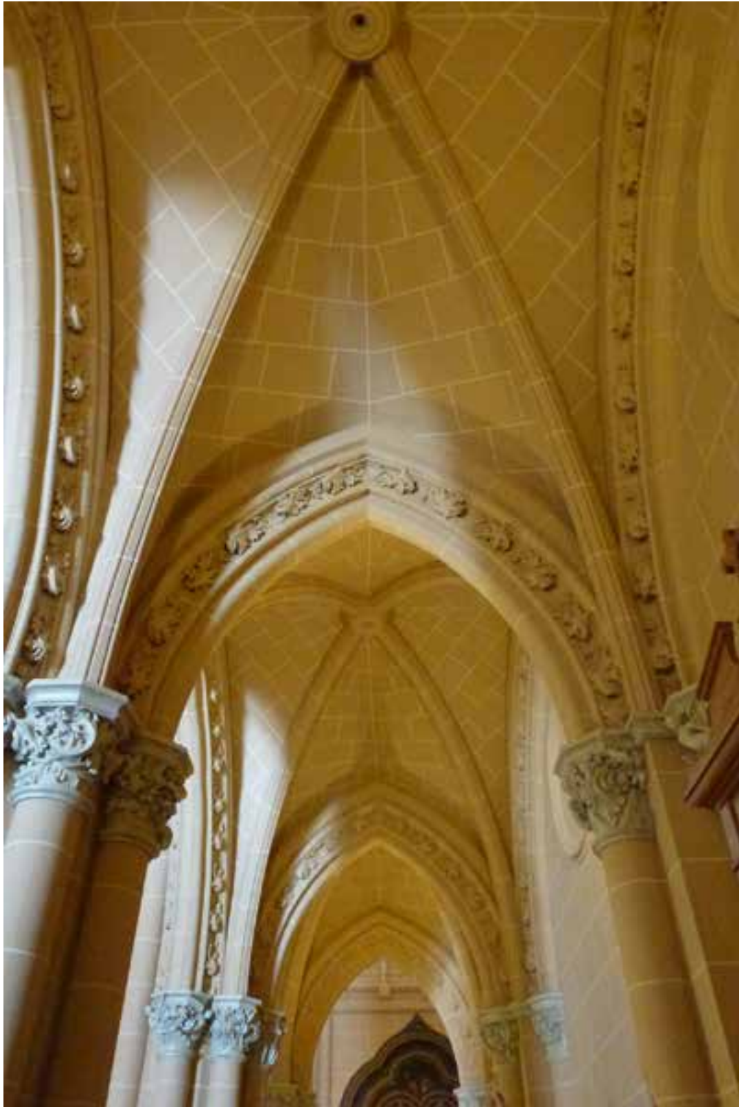
Bóvedas nave lateral
