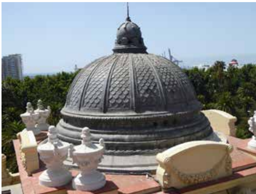
Cúpula sobre torre angular
