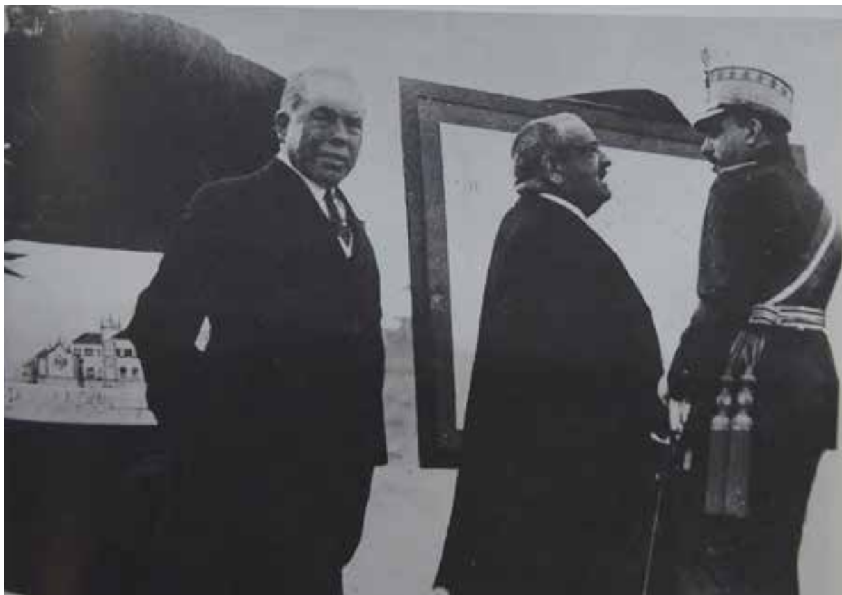
Colocación de la 1ª piedra por los Reyes
