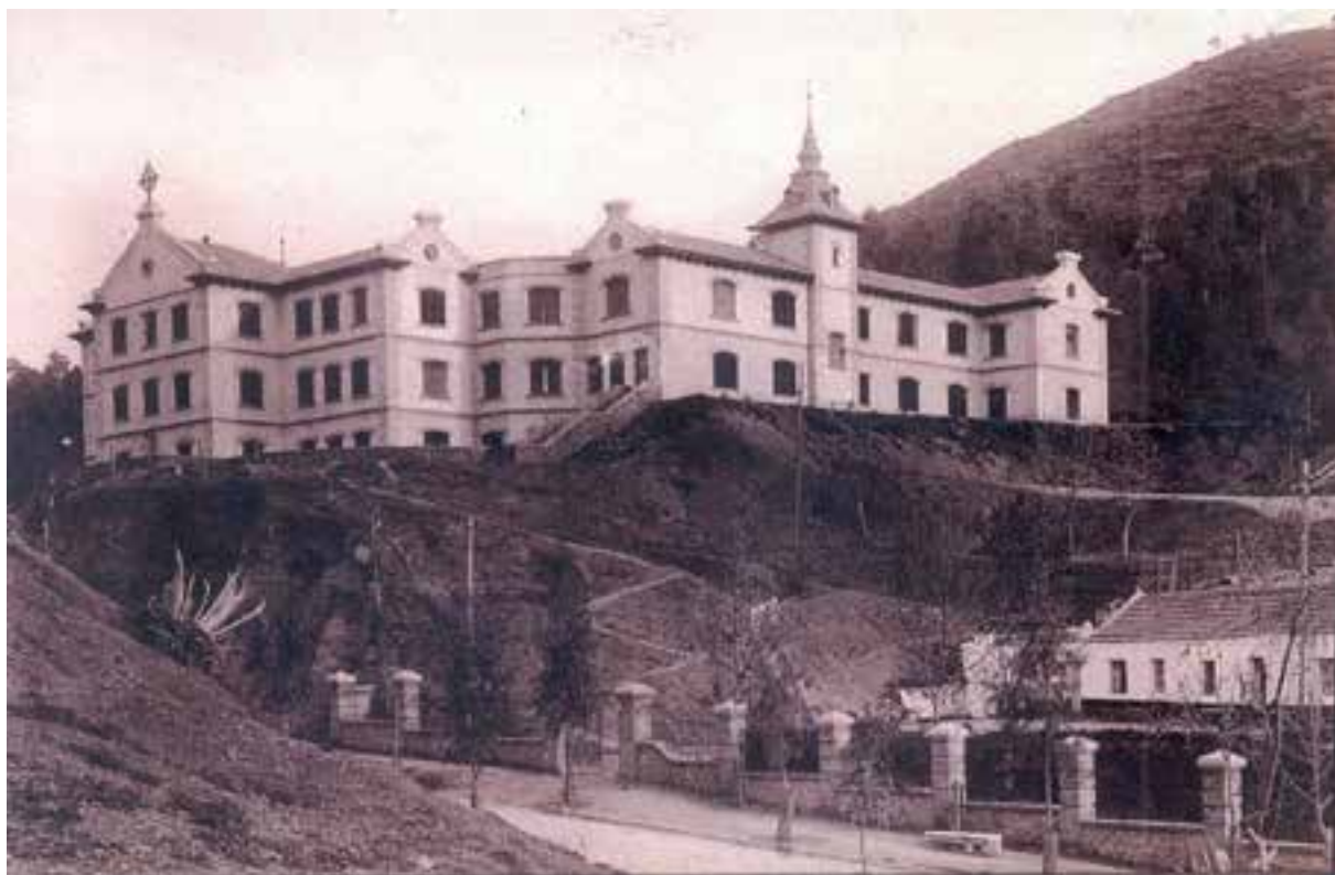
Foto antigua desde la entrada
