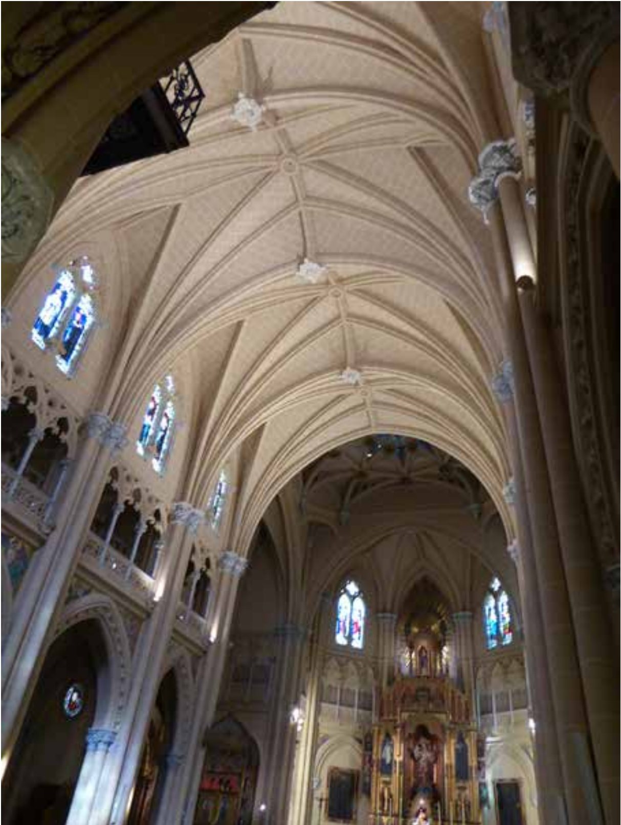
Bóvedas nave central
