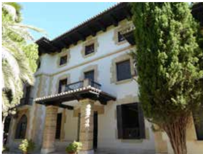
Pórtico de entrada
