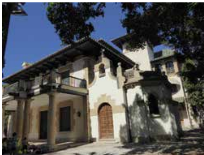
Fachada este y capilla
