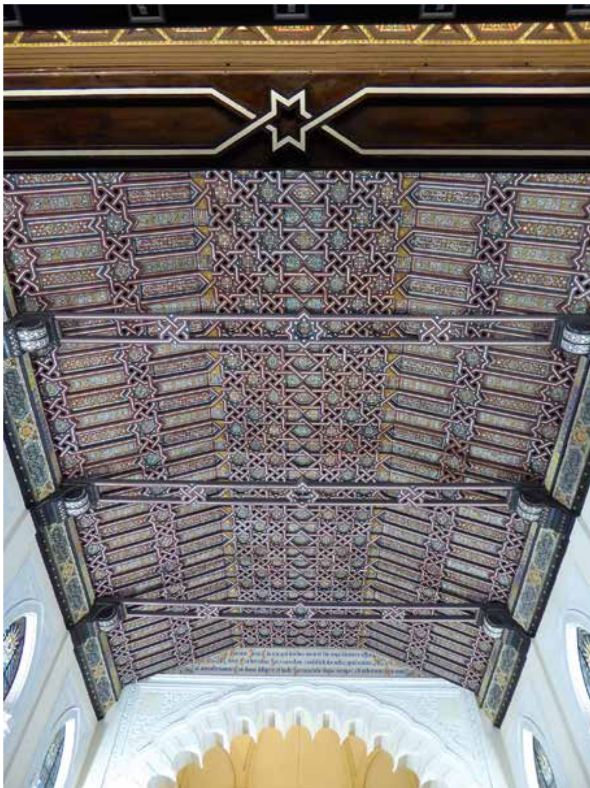
Vista general armadura
