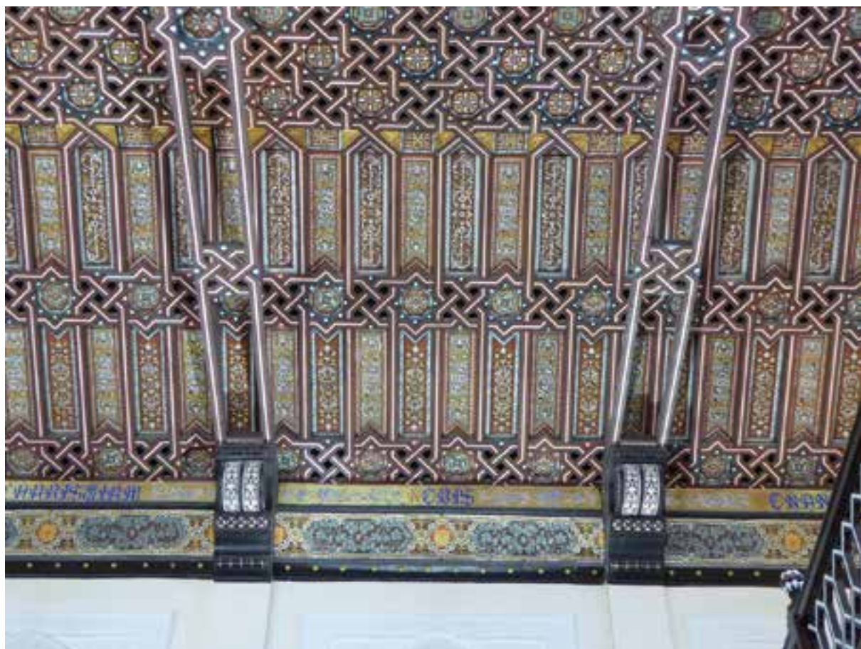
Vista parcial de armadura
