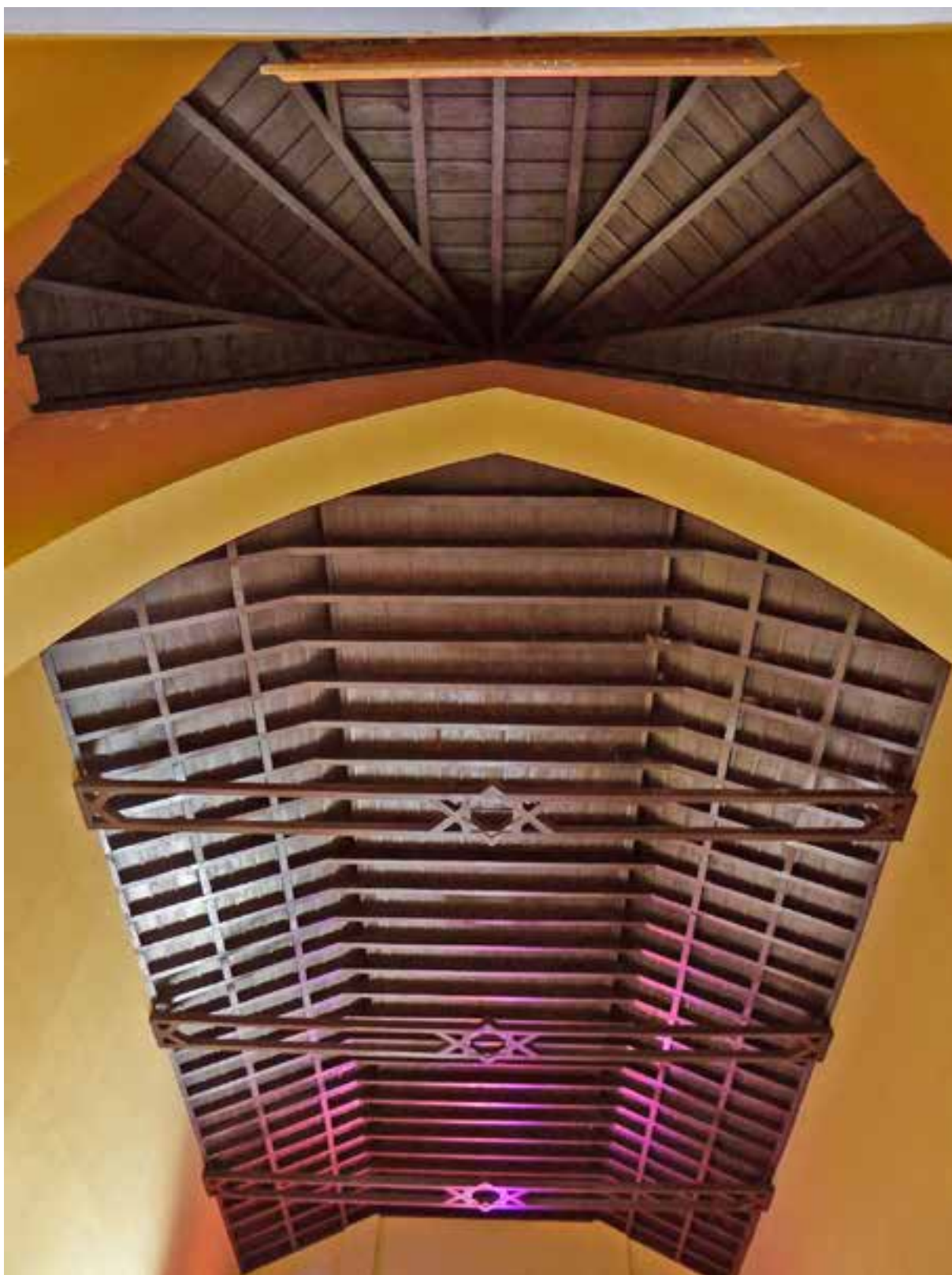
Foto armadura de la nave y presbiterio
