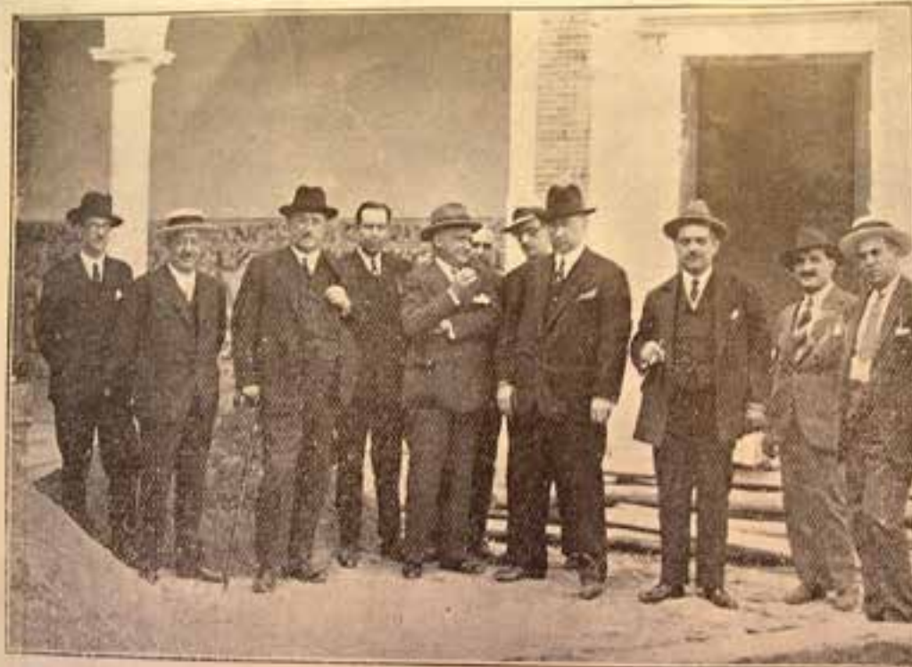
El autor del poblón de Málaga, Sr. Guerrero Strachan, visita las obras, acompañado de los Sres. Cano Ortega, Escobar Acosta y periodistas sevillanos y malagueños
