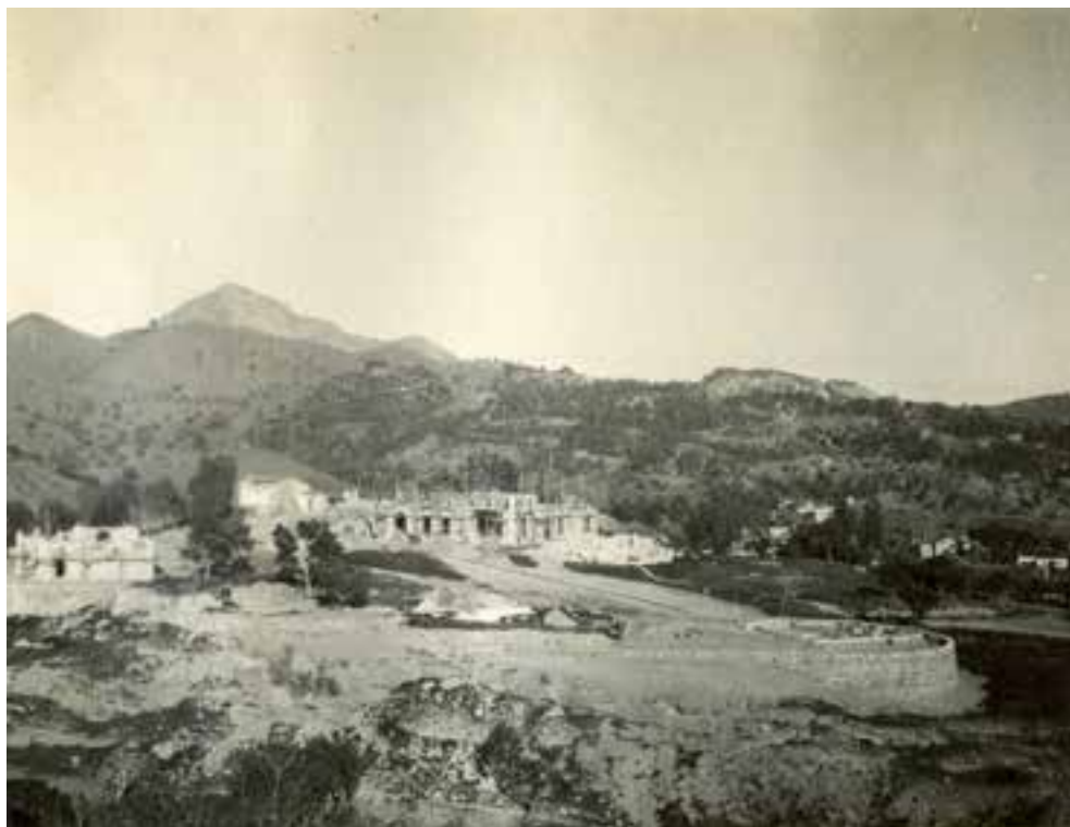
Inicio de las obras
