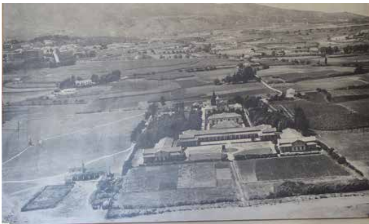
Foto antigua, vista general
