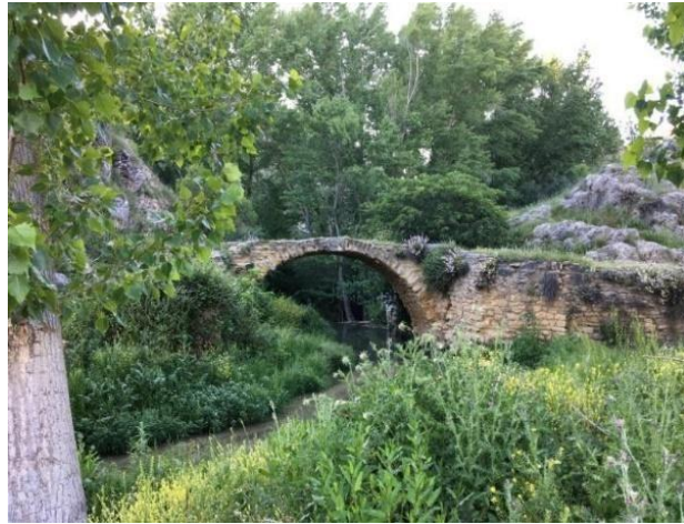
Fotografía 12. El puente romano.
