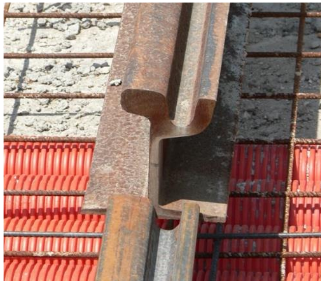
Figura 8. Carril de garganta o Phoenix [17]
