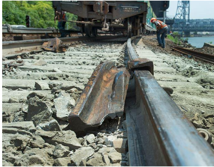
Figura 28. Fotografía encarrilador Metro-North Derailment Recovery [10]
