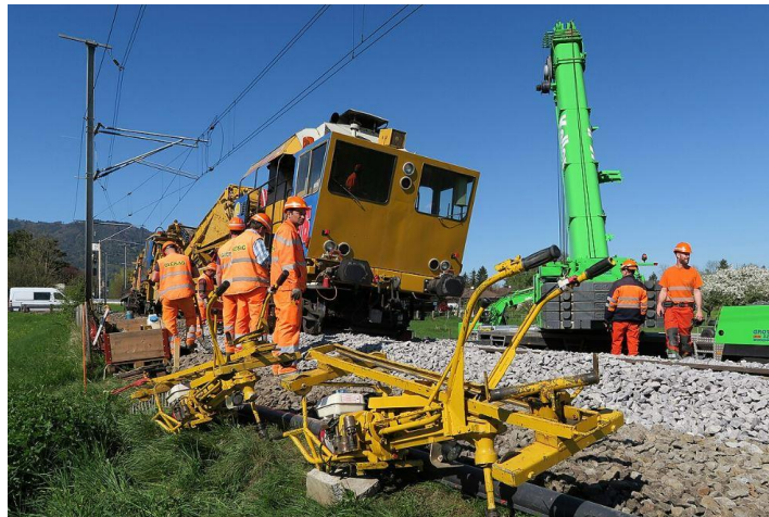
Figura 1. Trabajos de encarrilamiento con grúa [8]
