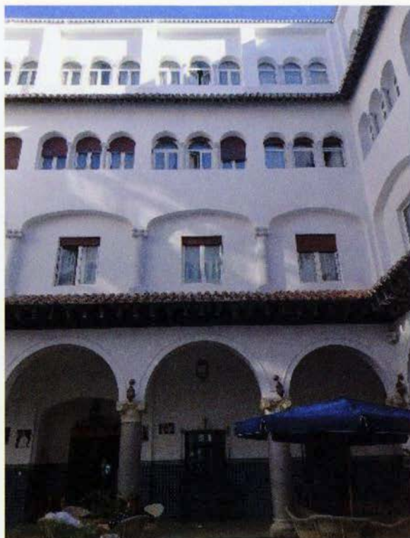
Vista actual del patio
