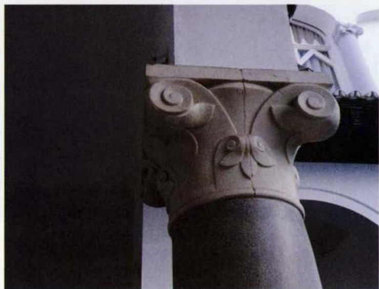
Detalles de la columna y capitel, estado actual
