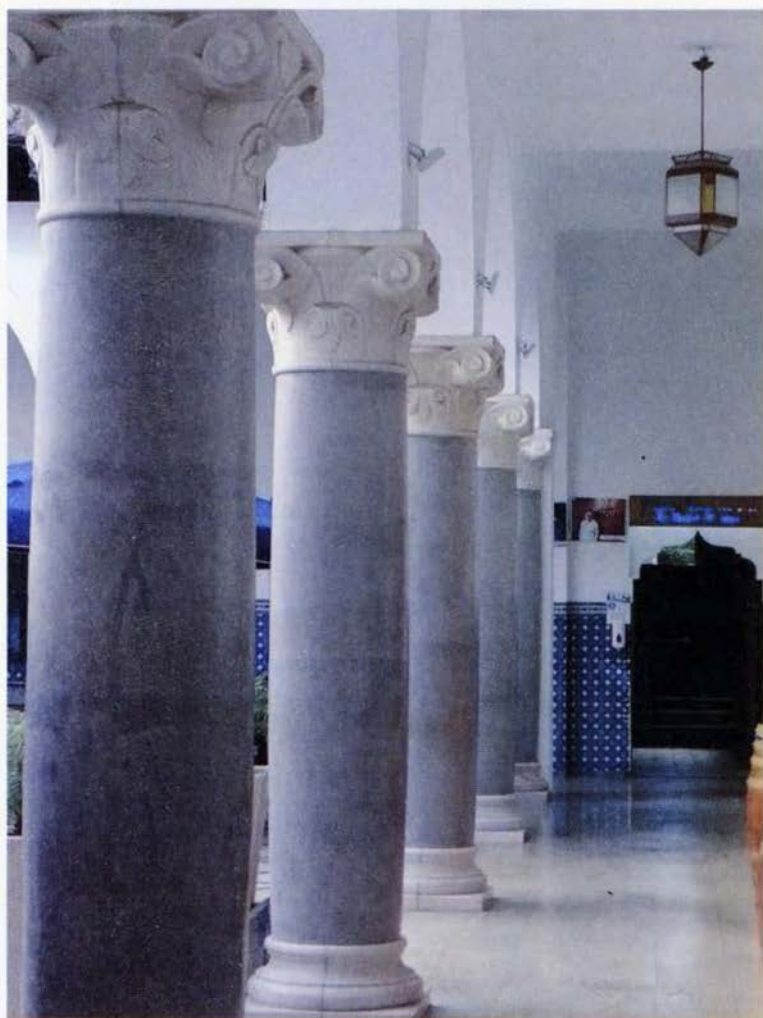
Columnata, estado actual
