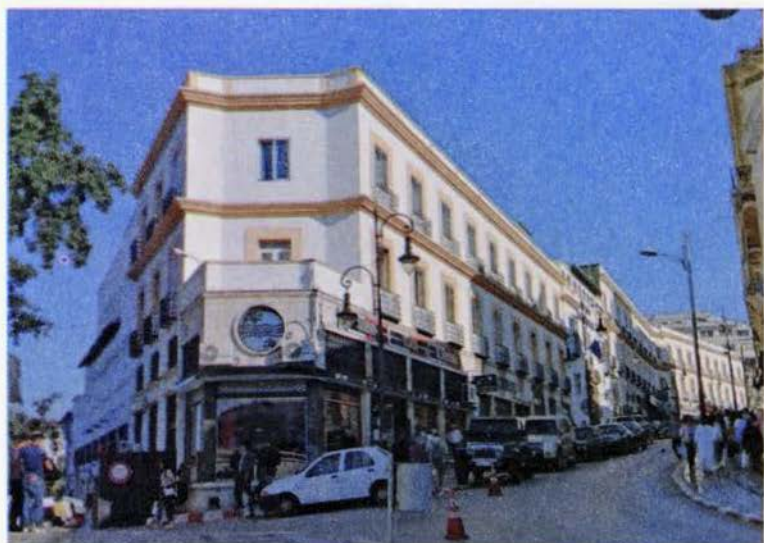
Vista de la fachada principal del hotel en toda su extensión , vista actual
