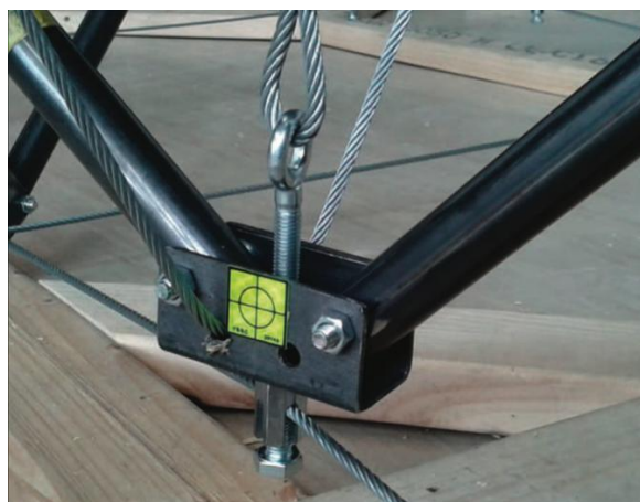
Figura 32. Ejemplo de nudo de conexión de dos barras empleado como referencia conceptual
