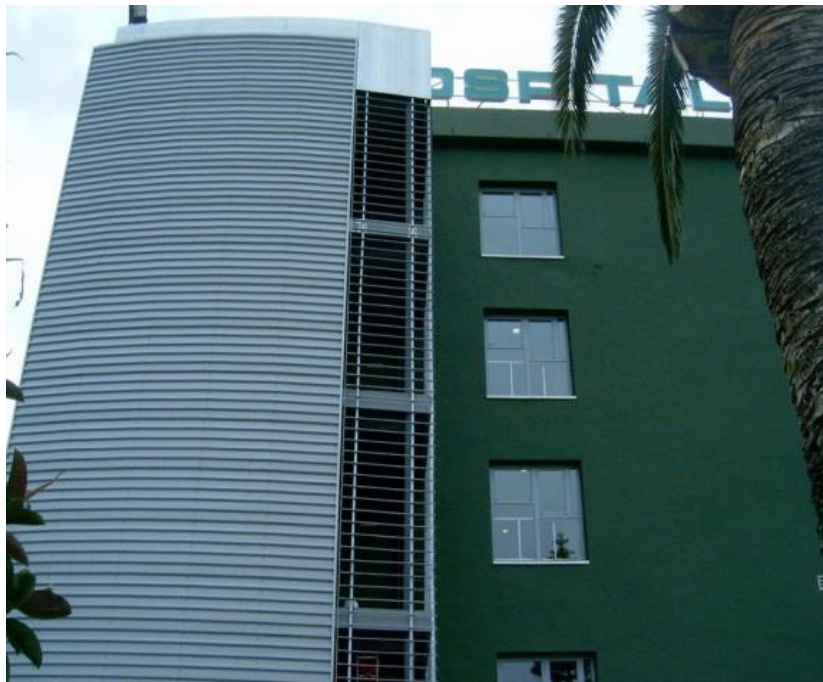
Figura 5.14 Hospital Comarcal de la Axarquía
