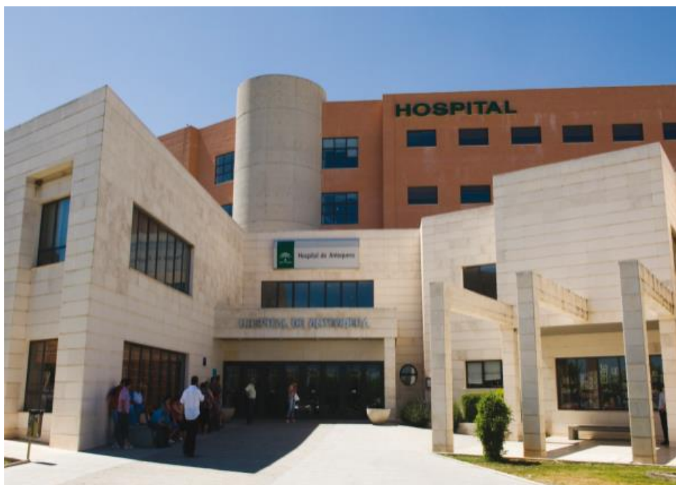
Figura 5.20 Hospital Comarcal de Antequera
