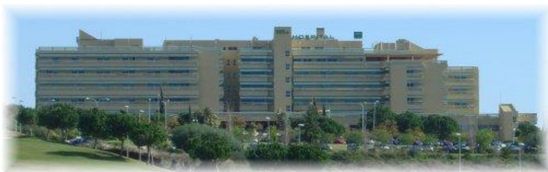
Figura 5.18. Hospital Comarcal Costa del Sol. Marbella 171
