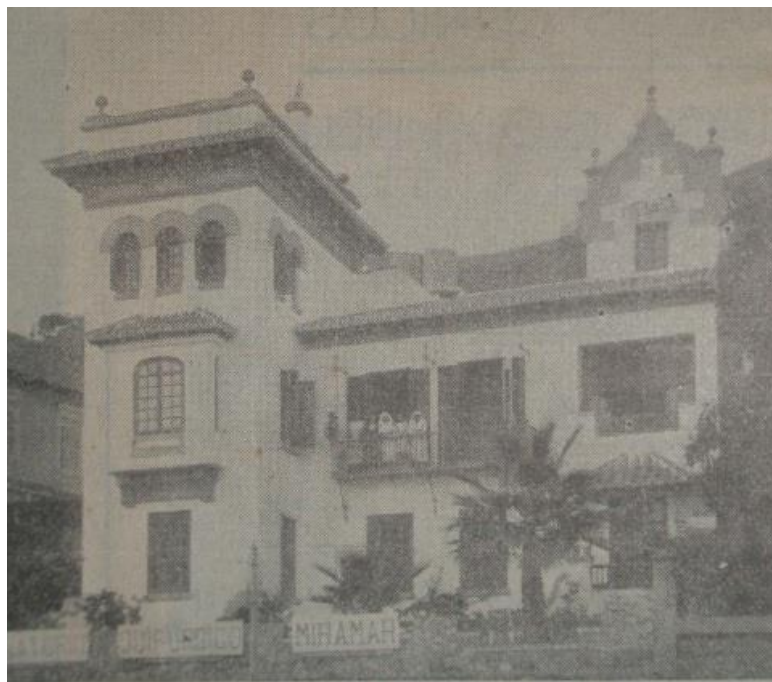
Figura 4.39. Sanatorio Miramar (Diario SUR)
