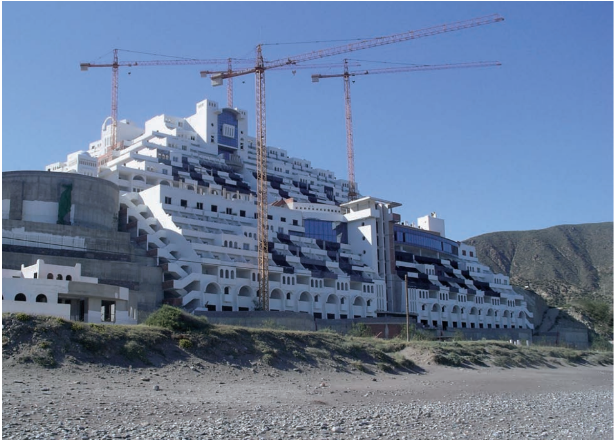
Figure 6 - Etat de la construction de l'hôtel de l'Alcarrobico, le 20 avril 2009 (© Araque Jiménez et Crespo Guerrero).
