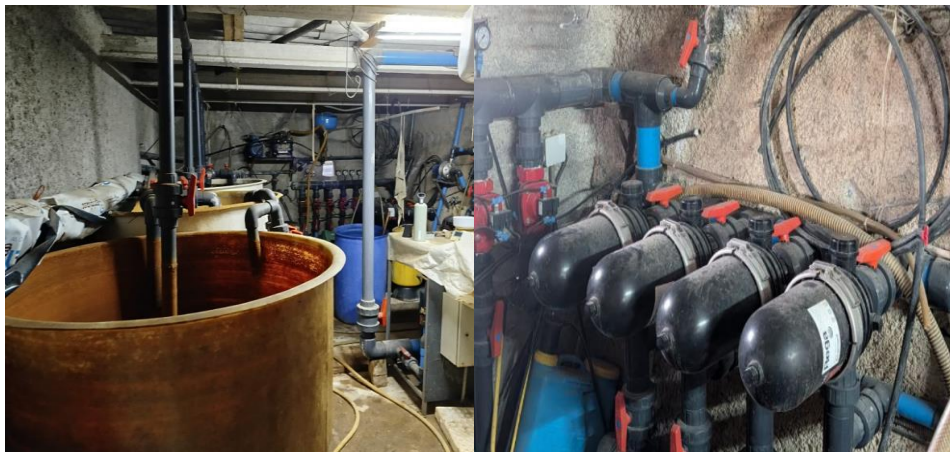
Ilustración 41. Riego y fertilización (Fuente Autoría Propia 2025).
