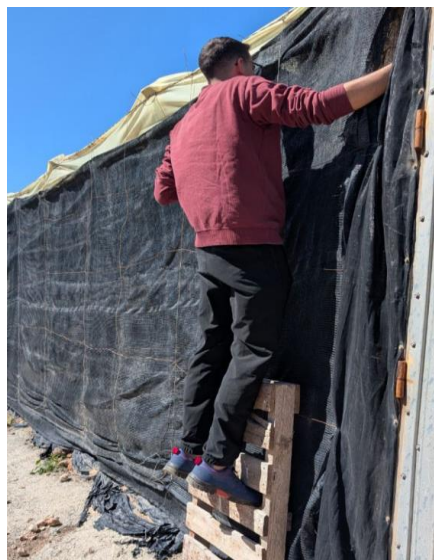
Ilustración 52. Caídas a distinto nivel (Fuente Autoría Propia 2025).
