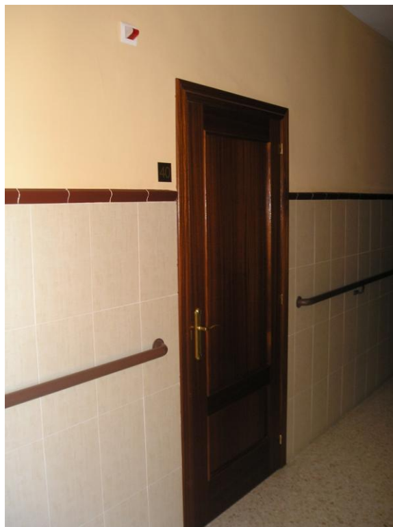
Dispositivo de necesidad de ayuda en habitación.
