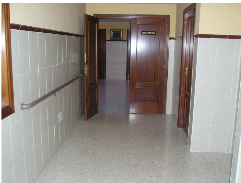
Vista de pasillo I.
