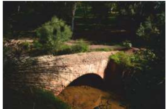
Fig. 8 – Restos de conducción cubierta y pequeño arco de fábrica de ladrillo sobre el Arroyo de Teatinos, Aguas de la Trinidad (foto Celia López-Bravo, 2021)
