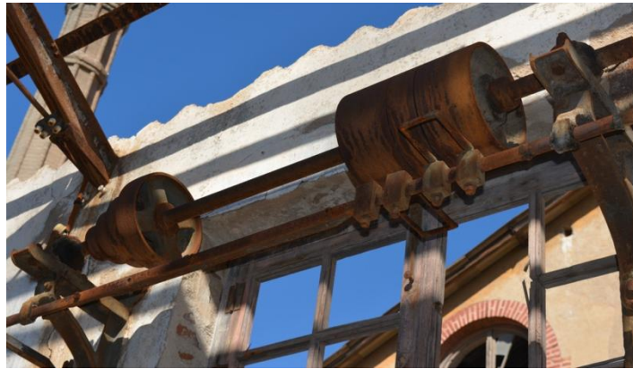
Figura 64. Sistema de poleas, cambio de velocidades
