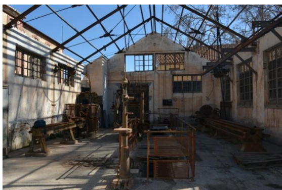
Figura 31. Vallas de protección puestas
