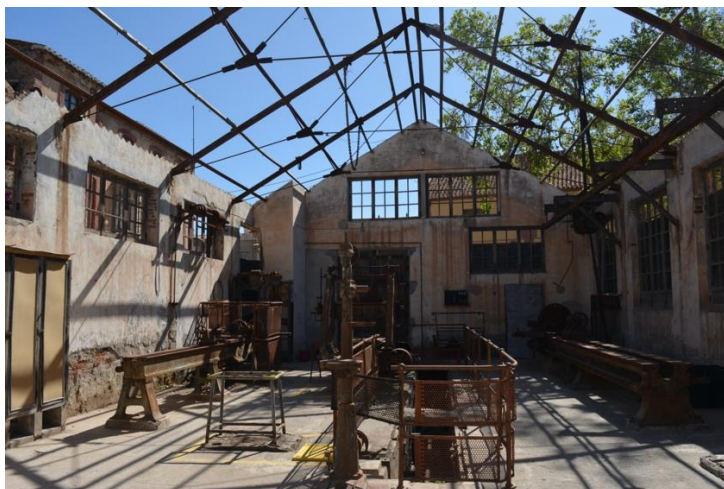
Figura 35. Vista general, mejora del espacio
