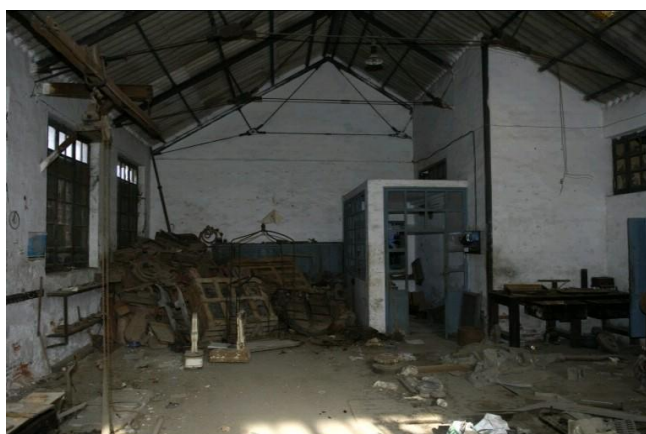
Figura 24. Estado del taller mecánico en torno al momento del cierre de la fábrica, imagen cedida por Alberto
