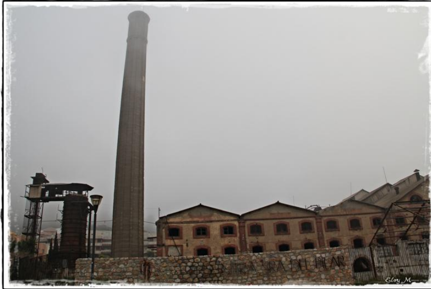
Figura 12. Fachada de la Fábrica de Nuestra Señora del Pilar[29]
