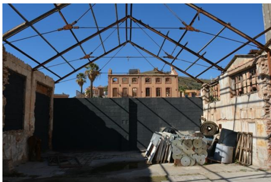
Figura 33. Vista general del espacio
