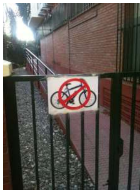
Rampa de Acceso para discapacitados
