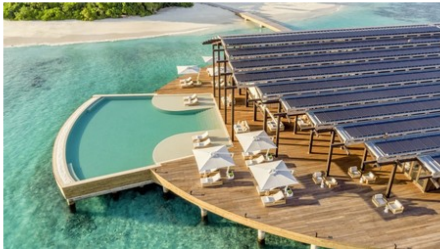
Figura 1.3 Placas solares. Fuente: Placa solar hotel, 2019
