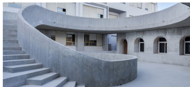
10. Patio interior. Facultad Bellas Artes, Málaga
