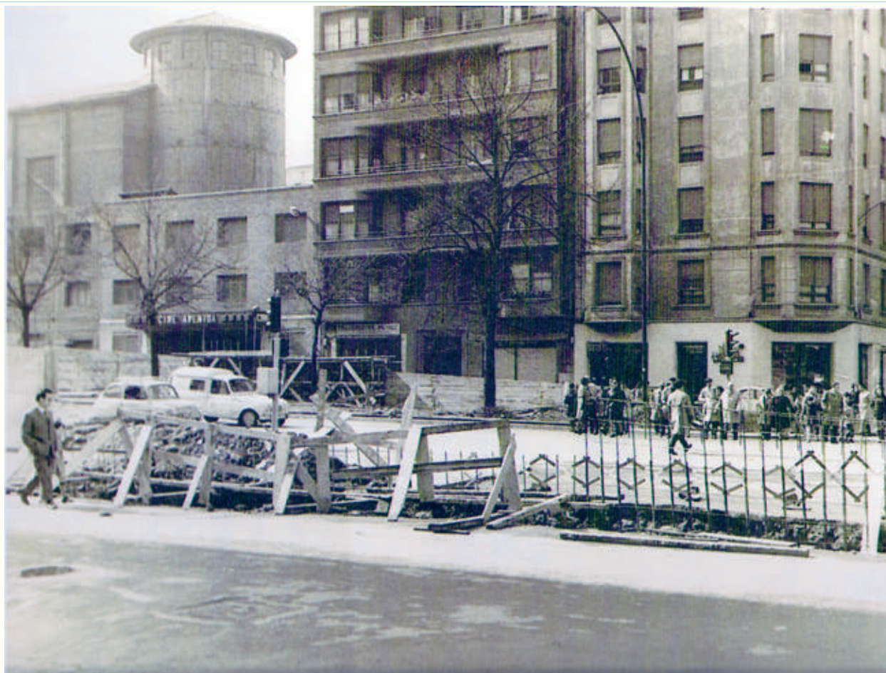
Obras de acondicionamiento de la antigua autopista de entrada a Bilbao en 1970. Al fondo se puede ver el cine Avenida
