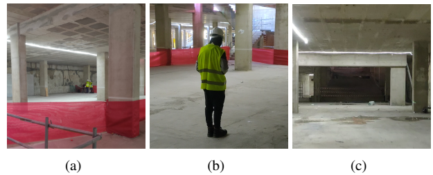
Fig. 1: Imágenes del escenario real de la planta inferior y de la toma de medidas
