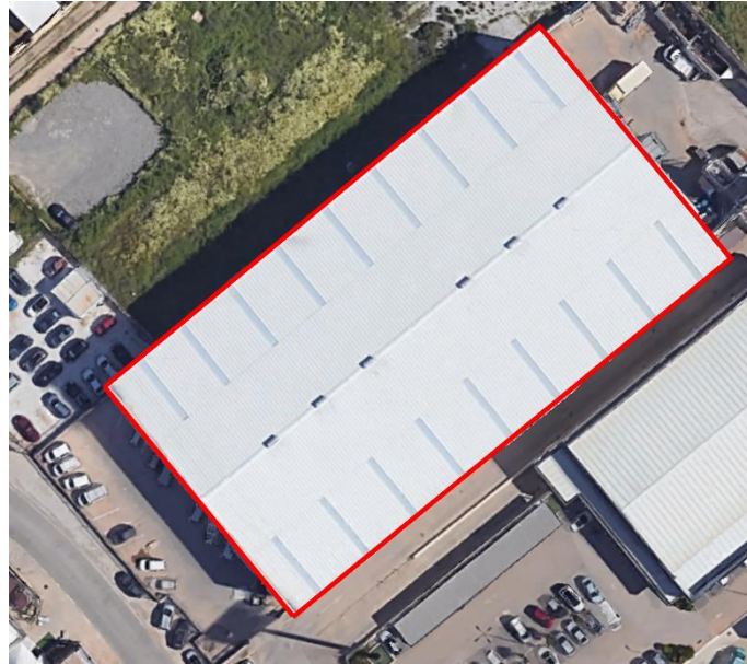
Figura 5. Cubierta total disponible para la instalación fotovoltaica. Adaptada de [1].
