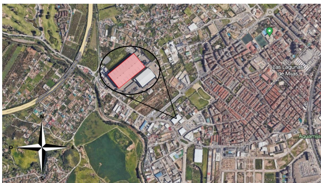
Figura 1. Emplazamiento de la nave industrial de la empresa Maderas Santaella S.L. Adaptada de [1].
