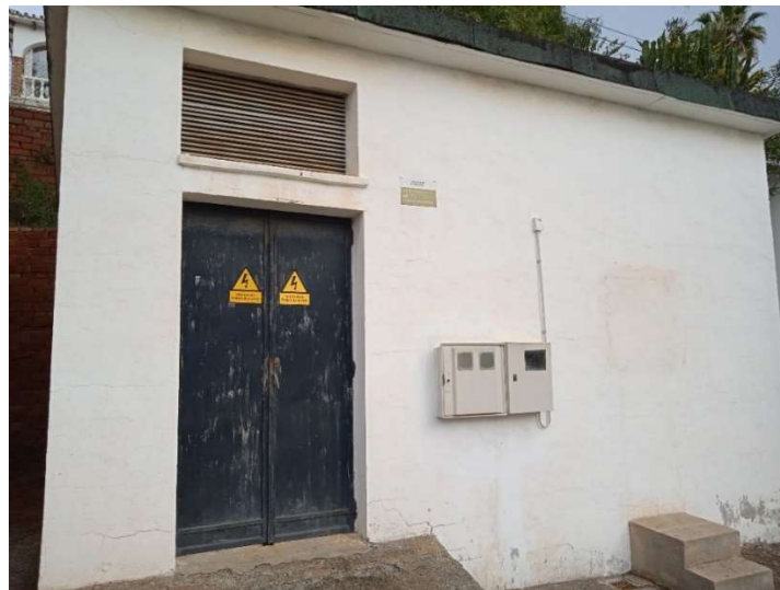
Figura 3. Ventilación natural, rejilla superior a puerta de acceso.
