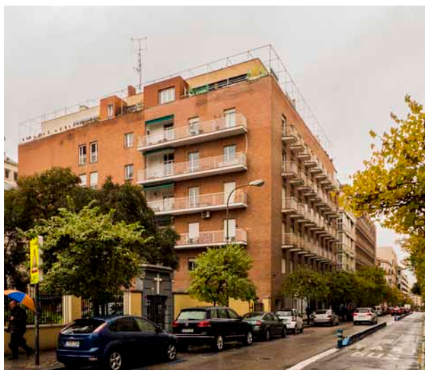
Edificio de viviendas en la c/Fernando El católico
