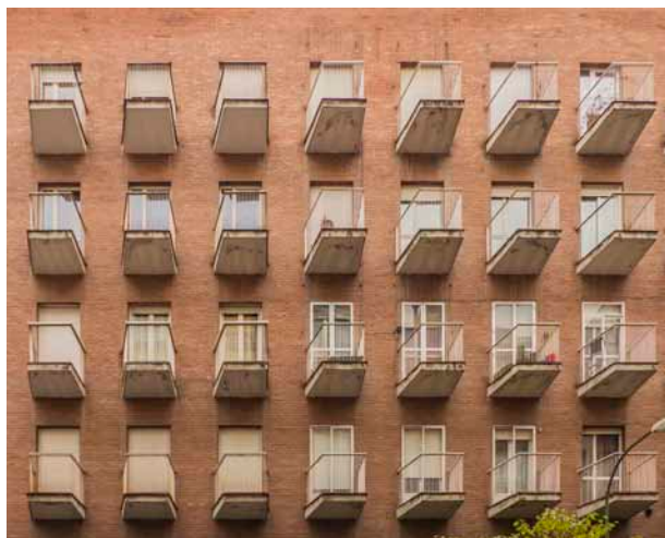
Edificio de viviendas en la c/Fernando El católico
