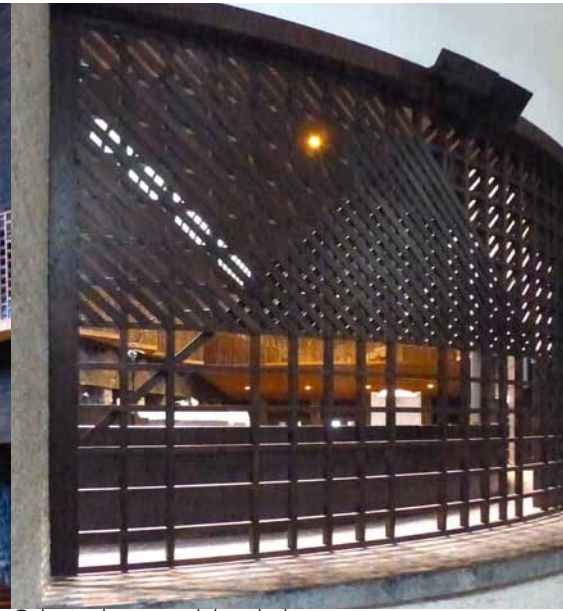
Celosía de cierre del ambulatorio
