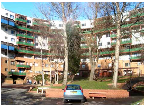
BYKERWALL. Vistas de las fachadas interiores
