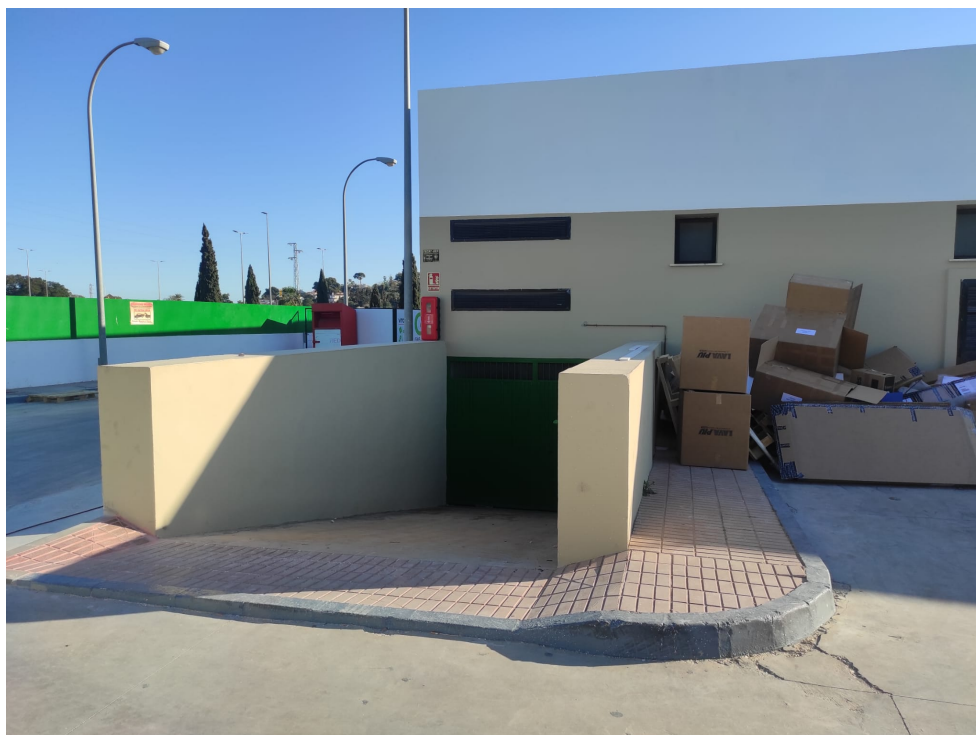
Fig.8 Acceso Planta Baja.
