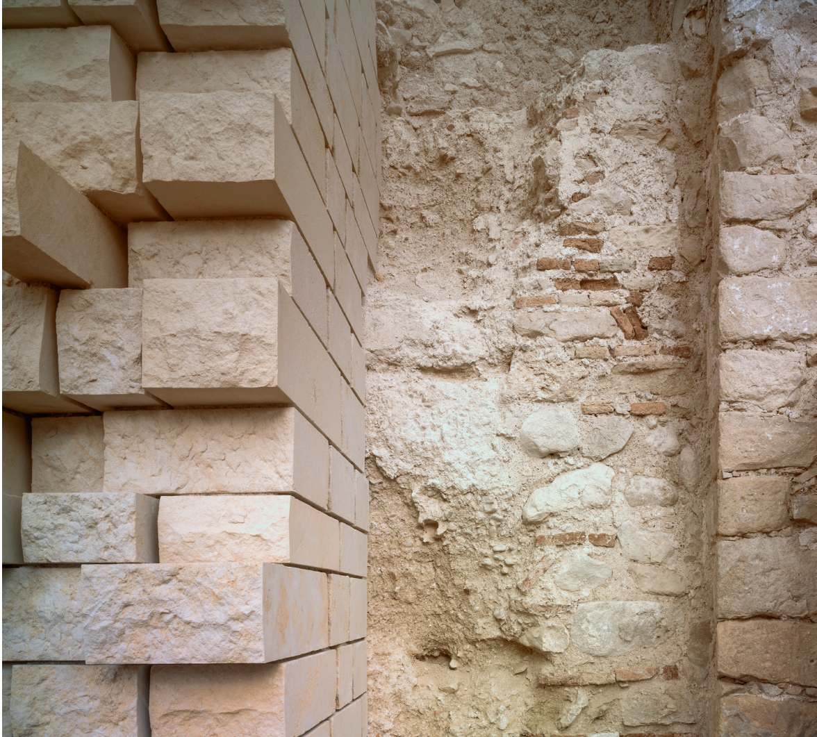
Figura 15. Fábricas históricas del Lienzo Oeste y fábricas de reintegración de la muralla de la Almedina de bloques de piedra arenisca (fot. Jesús Granada, 2015).
