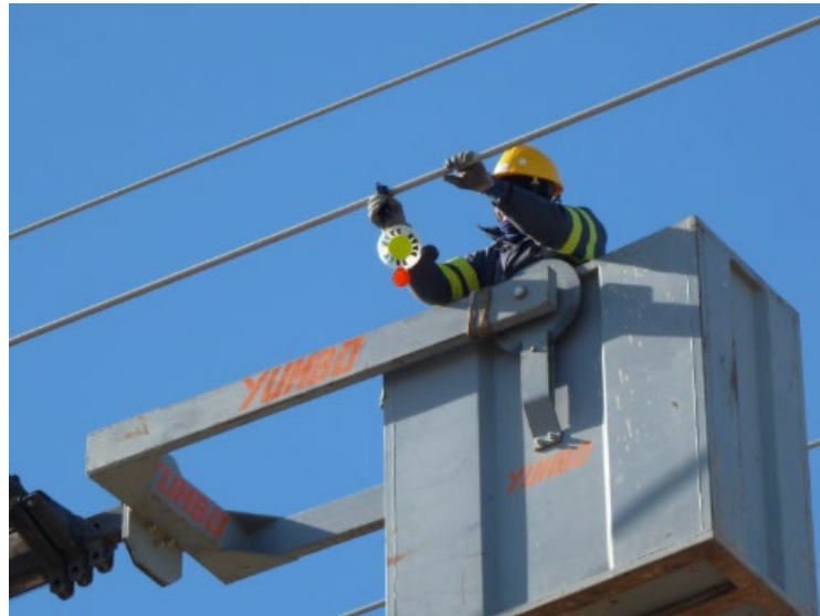
Figura 47. Dispositivos CROCFAST siendo instalados
