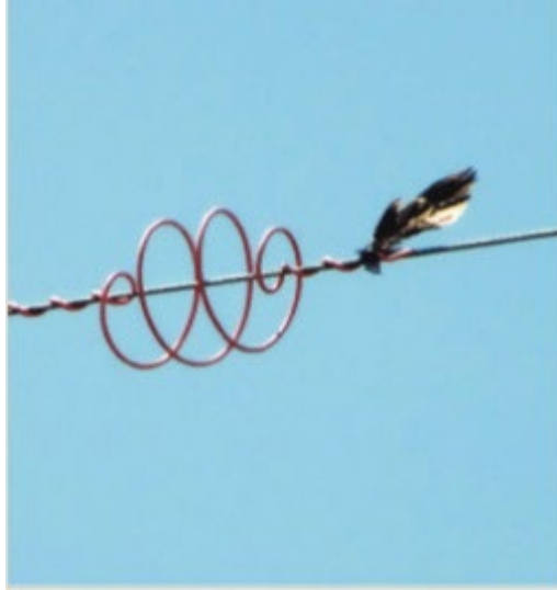
Figura 46. Espiral anticolidión poco eficaz (Garrido, 2015)
