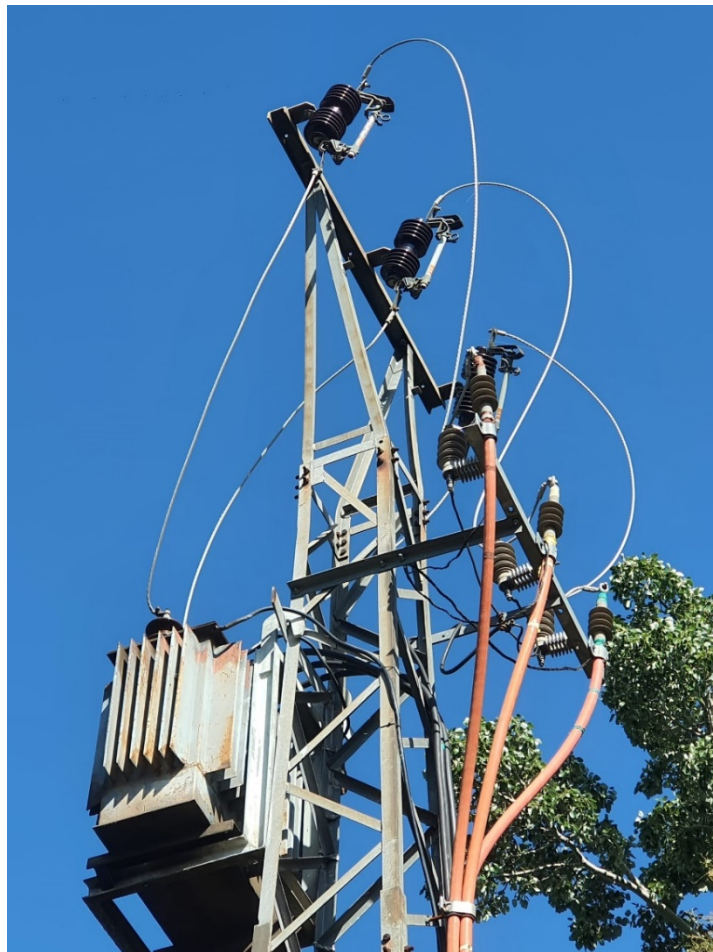
Figura 11. Apoyo no aislado
