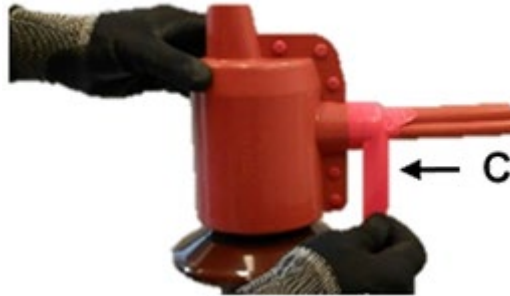
Figura 40. Colocación de la cinta de silicona autobulcanizable (ENVERTEC S.L., 2020)
