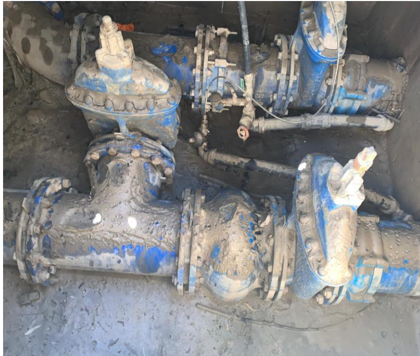
Figura 14. Impulsión desde el Pozo Ranney hasta el Depósito 1
