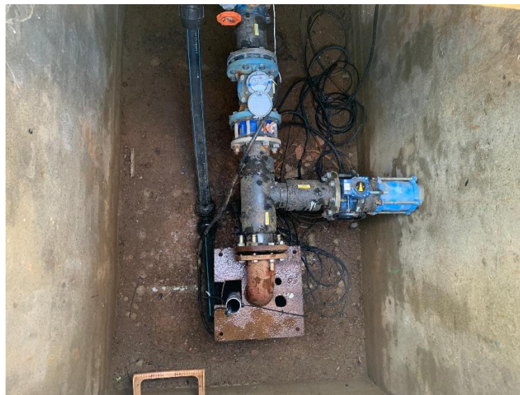
Figura 12. Instalación bombeo del Sonda 4
