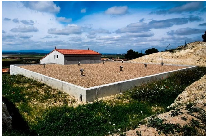
Figura 4. Depósito de tipo semienterrado de tipo C
