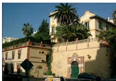
850. Estado actual. Avance de la nueva fachada del pabellón principal con los dos cuerpos laterales añadidos y el porche.
