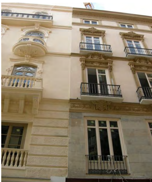
614. Encuentro de los edificios de Ruiz y Rivera en Sebastián Souvirón. Decalaje en las líneas de impostas.
