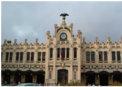
550. Estación del Norte de Valencia, Ribes y Grasset (1906-1917).
