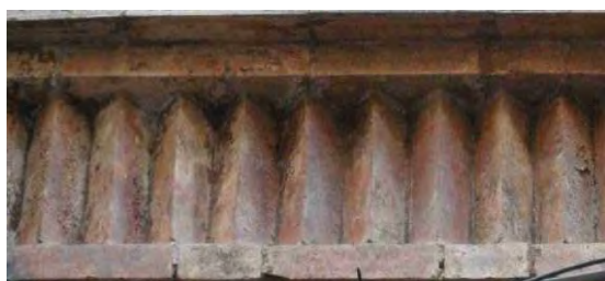
918. Franja de ladrillo triscado.
