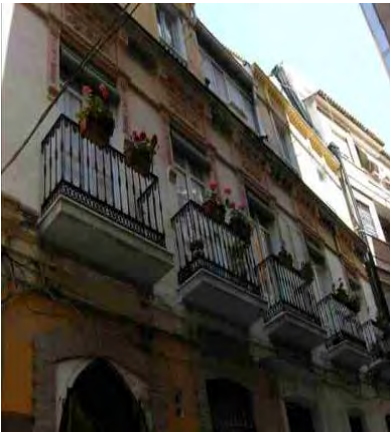
279. Fachada del edificio n° 13 de Juan de Padilla
