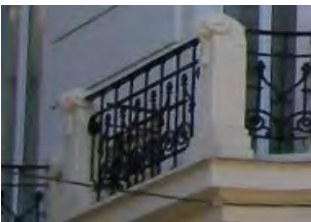
718. Machones de los balcones en Alameda 21.
