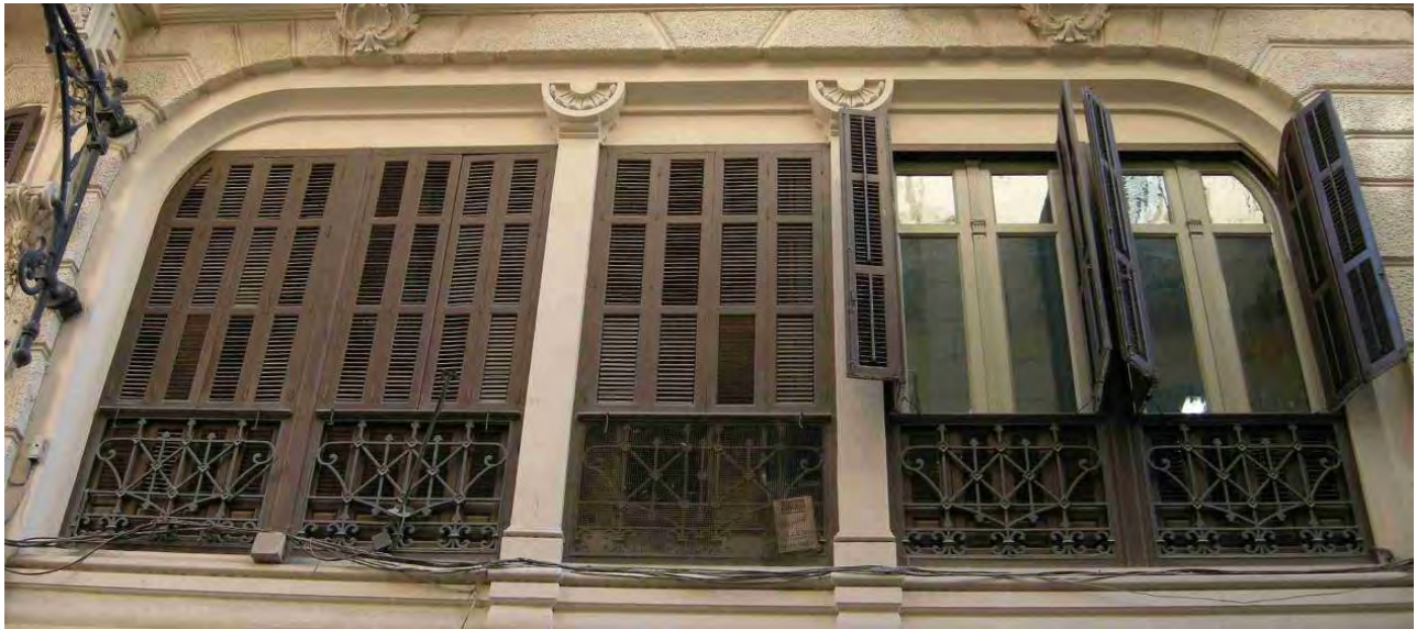
680. Vanos de la entreplanta en la fachada a calle Especería.
