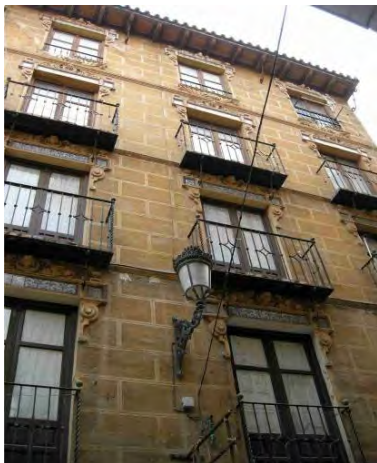
946. Fachada del edificio n°5 de Cintería.
