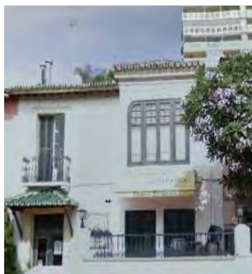
968. Estado actual de la casa en Paseo de Sancha 48.
