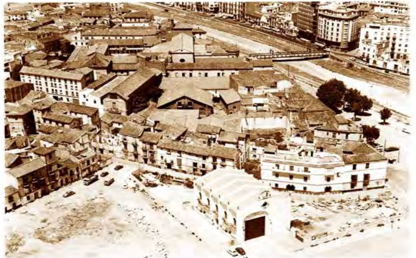
101. Edificaciones sobre el antiguo muro.
