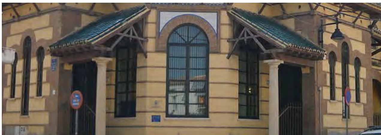
807. Vista de la doble entrada desde la plaza de Dña Trinidad Grund.
