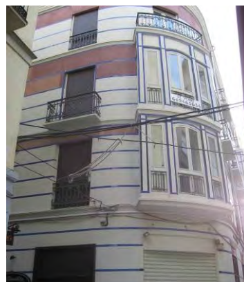
350. Vista del cubillo del edificio 5 de Lazcano
