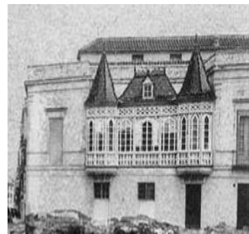
435. Vista de la fachada al Guadalmedina de la casa Scholtz. Detalle.
