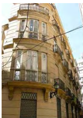
354. Vista de la esquina en cubillo y fachada a Lazcano del edificio n° 7.
