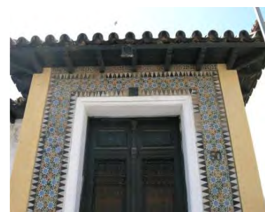
792. Fachada del cuerpo avanzado. Recercado de cerámica y alero volado de madera.
