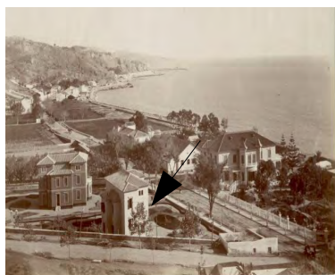
798. Situación de la casa entre la Carretera Málaga-Almería y el Camino Nuevo.
