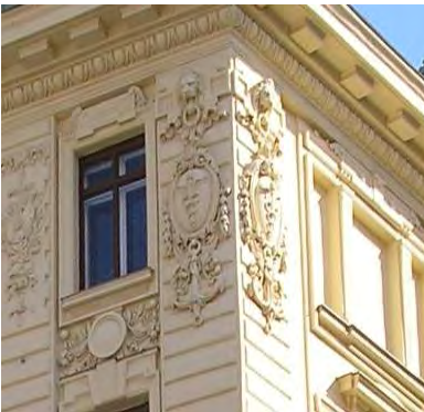
710. Edificio de oficinas Anker-Haus. Detalle de los decorados colgantes con medallones y cabezas de león. Otto Wagner 1895.
