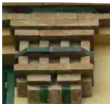
881. Gómez Pallete 7 . Detalle de ménsula.
