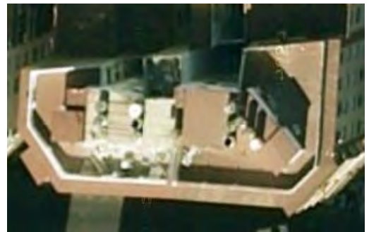
59. Vista aérea del edificio que ocupa la parcelación originaria, actual calle Don Juan de Austria 41-43.
