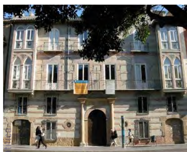
823. Fachada actual a la Alameda.
