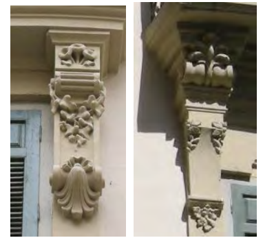
387. Decoración de ménsulas en piso primero (izq.) y segundo.
