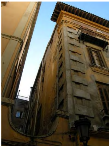
973. Vista desde la calle Trinidad Grund: Encuentro de la fachada a esta calle con la posterior. Esquina cosida con falso sillar, patio y muro de unión con el edificio contiguo.
