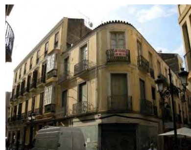
387. Vista de los dos cuerpos que componen el edificio de Méndez Núñez 5, desde la esquina con Juan de Padilla y el edificio entre ellos.
