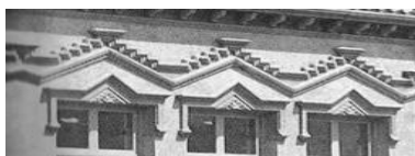
1096. Escuelas graduadas (derribada), Albacete. Detalle.
