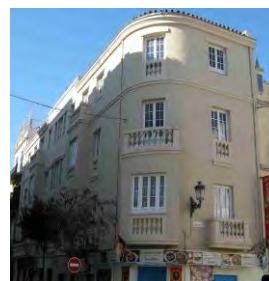
306. Vista de la esquina del edificio con fachadas a Cárcer y Madre de Dios.
