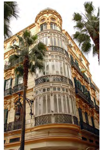
585. Edificio de Alarcón Luján 1, Málaga.
