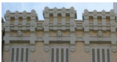
578. Terminación de la fachada en peinetas.
