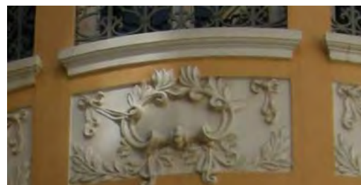
745. Cartelas vacías en recuadros, marcan la entreplanta entre el piso primero y el segundo.
