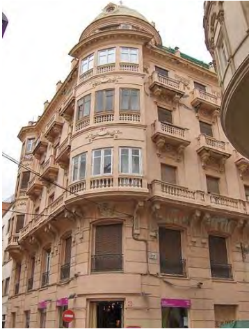
690. Vista de la articulación de las dos fachadas que componen el edificio, mediante cubillo con mirador entre las calles Moreno Carbonero y Sebastián Souvirón.
