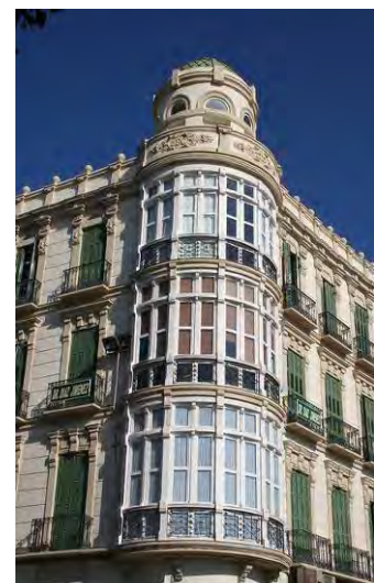
586. Edificio en Avda Juan Carlos I, 2, Melilla.
