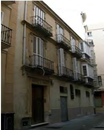
357. Edificio n° 11 de Convalecientes.
