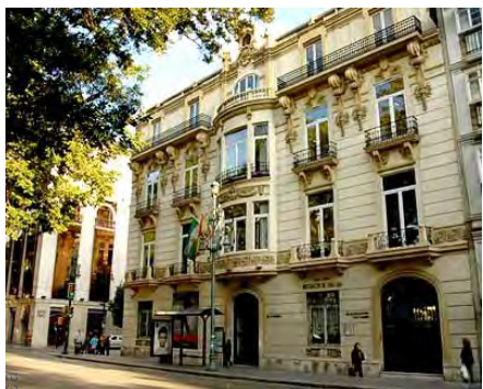
704. Fachada a la Alameda en donde se instaló la nueva portada.
