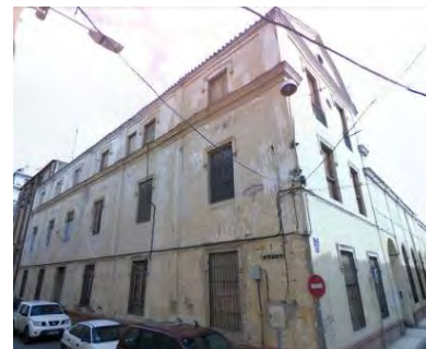
9. Vista entre las calles Purificación y Wad-Ras del edificio original de la fábrica de electricidad,
