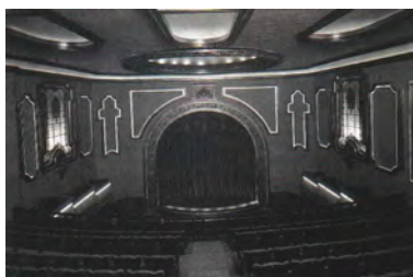
1134. Interior de la sala antes de la rehabilitación.
