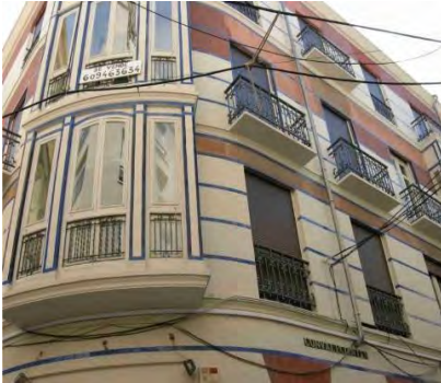
884. Mirador en cubillo y fachada a Convalecientes.
