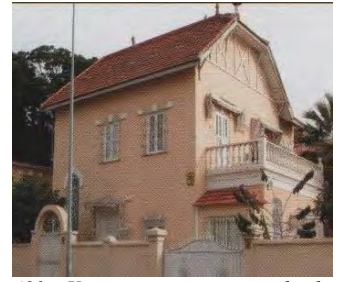
490. Vista suroeste, antes de la última reforma.
