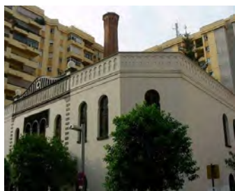
779. Edificio de Brotons en la actualidad. Fachada principal con triada de arcos insertos en álfiz. Vanos y arquillos de cornisa en arco de herradura.
