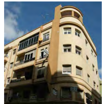
1303. Edificio en calle Mármoles 30.
