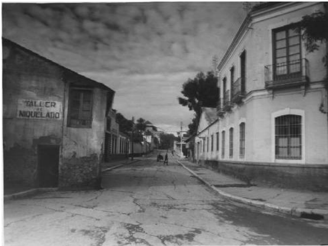
63. Vista de la calle de La Regente desde Don Juan de Austria, c.a. 1950. A la izquierda una antigua casa de la plaza de Trafalgar, aún sin alinear.
