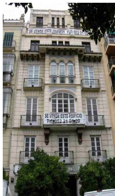
953. Cortina del Muelle 9. Fachada.
