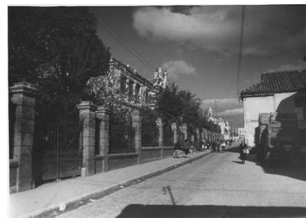
72. Acera del Campillo alineada en 1916 con la construcción del Grupo escolar Bergamín (a la izquierda de la imagen).
