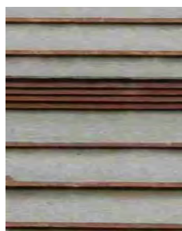
882. Testero del nº 7 de Gómez Pallete. Franjas de ladrillo escalonados y lineales.
