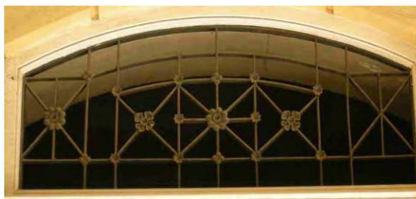
605. Reja en vano de planta baja.
