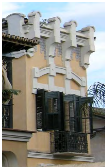
556. Villa Suecia. Cuerpo derecho de la fachada principal.
