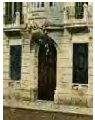
708. Portada originaria a calle Córdoba. Peana bajo el mirador y gran cartela, que igualmente decoraba el de la fachada a la Alameda, y que hoy no existen.
