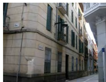
324. Fachada a Marqués de Guadiaro del edificio nº 8.
