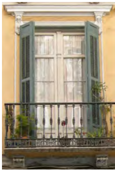
391. Vano con sobredintel y guardapolvo. Reja de corte recto.
