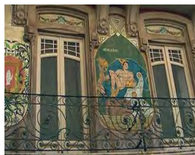
363. Fachada principal de la Casa Llagostera con el mismo diseño de barandilla en el exterior.
