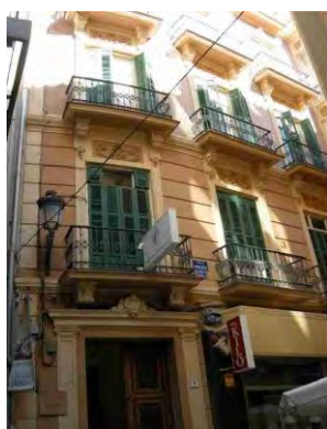
199 Fachada del edificio nº 7 de Marín García. Una curva suave sustituyó al ángulo que proyectaba el atirantado oficial antes de la rectificación.
