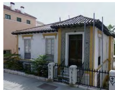
790. Casa en Paseo de Sancha 50. Fachada a la carretera.
