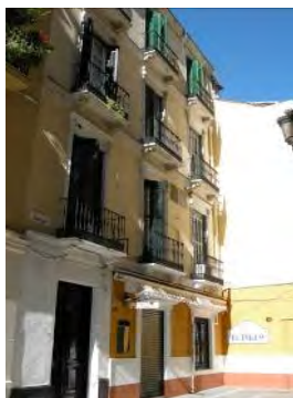
205. Fachada a Esparteros del edificio anterior. El edificio colindante marca la alineación antigua.
