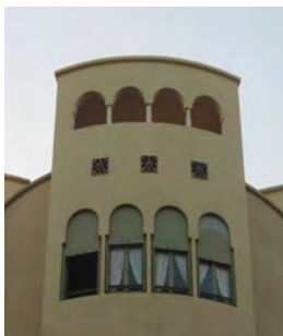
1078. Cister 19. Detalle de terminación de fachada (1927)
