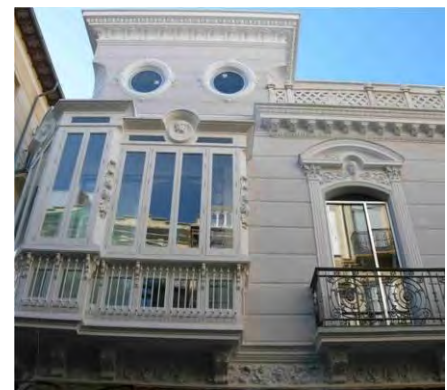
370. Fachada a Álamos, detalle del mirador y rejería del balcón.
