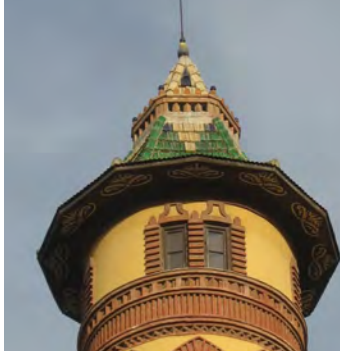
1094. Detalle de cubierta y del torreón
