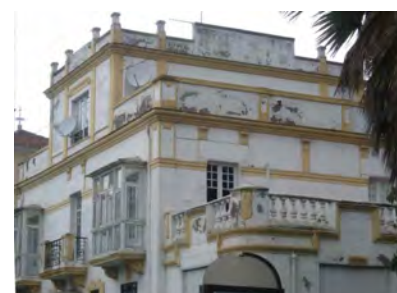
1036. Vista sureste. Cuerpo de esquinas curvadas, molduras escalonadas y formando recuadros.
