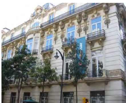
703. Fachada a calle Córdoba en la actualidad. La portada del edificio fue cambiada por una ventana.
