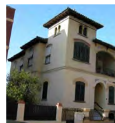
839. Vista de las dos fachadas. Casa 38.
