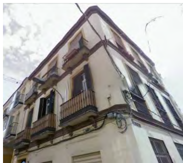
419. Vista de las dos fachadas.
