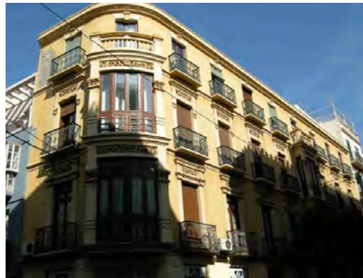
315. Vista del edificio nº 5 de Cárcer desde la calle Álamos.
