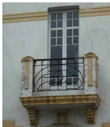
1038. Detalle de balcón. Modillones en ménsulas, machones con llagueado y franjas verticales alabeadas. Rejas de diseño curvado.
