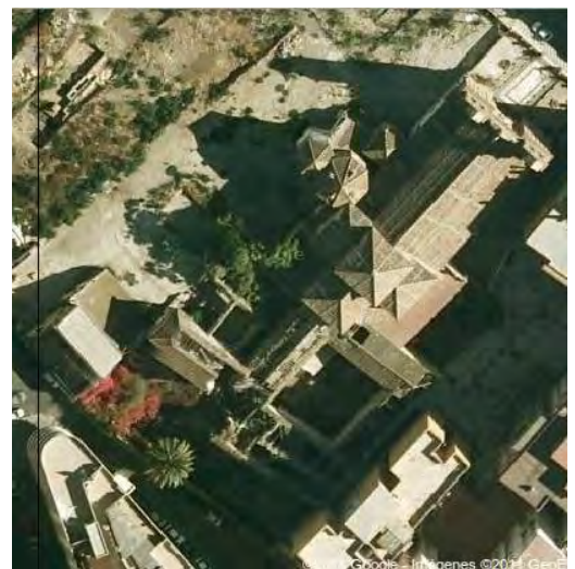
133. Estado actual de la zona.
