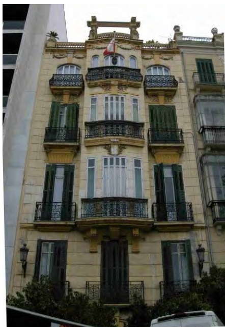
1009. Fachada a Cortina del Muelle.
