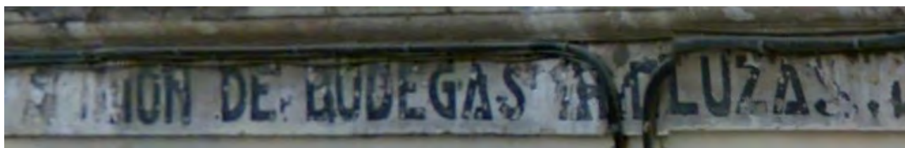
12. Unión de Bodegas Andaluzas, estado actual. Detalle .
