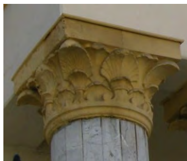
1047. Detalle de uno de los capiteles de las columnas porche.
