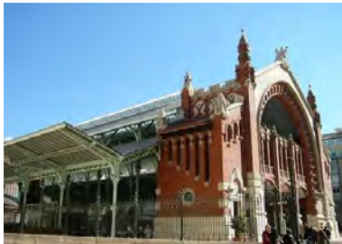
1087. Valencia, mercado de Colón. Arq. Municipal Francisco de Mora, inauguración 1916.
