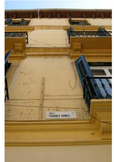
340. Detalle de fachada del edificio nº 8 de Méndez Núñez.
