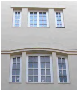
1057. Fachada a calle Cárcer: Detalle.
