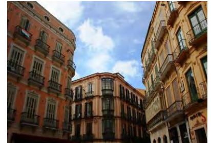
5. Calle Granada. Altura de edificios homogénea y proporcional a la anchura de la calle.
