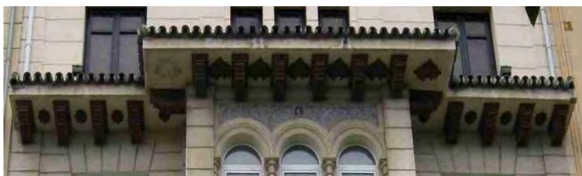
957. Cortina del Muelle 9. Detalle del tejado volado. Ménsulas de mampostería pintada.
