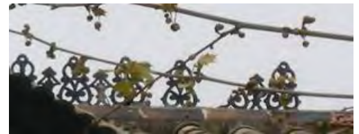
460. Crestería en Avda Juan Sebastian Elcano 117, iguales en Marcos Zapata 7 y en Pasaje de Sancha 1.
