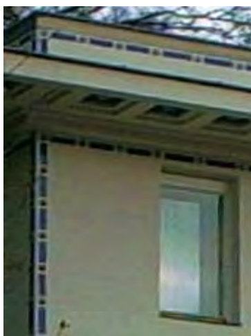
888. Villa Klein de Wagner. Detalle de la cerámica enmarcando el testero.
