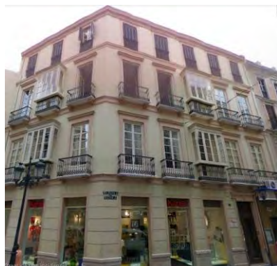
268. Edificio nº 12 de Méndez Núñez.
