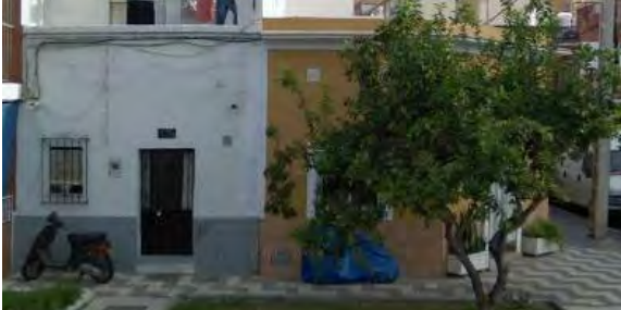
1228. Casa 135 en la actual Avda Salvador Allende.
