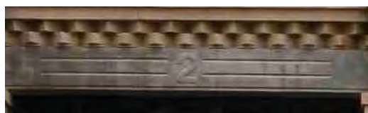
879. Cenefas de ladrillo triscado. Portada, detalle. Gómez Pallete 11.
