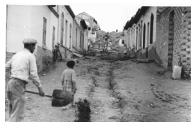
1297. Acometida de alcantarillado en calle Doña., barrio de San Miguel de Capuchinos.
