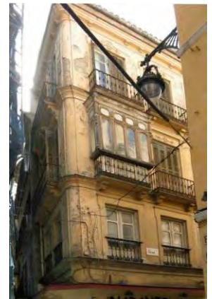
376. Fachada a calle San Juan
