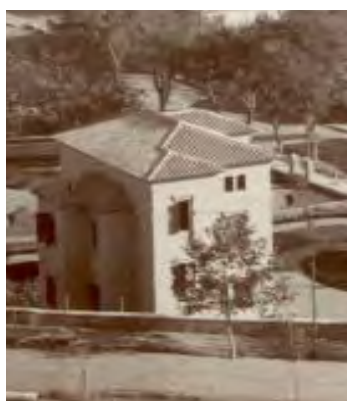
799. Vista de las fachadas norte y oeste, antes de los añadidos.
