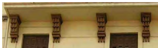
880. Ménsulas de ladrillo, escalonadas. Gómez Pallete 11.
