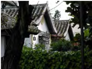
454. Detalle de fachada. Fernández Shaw, 14.
