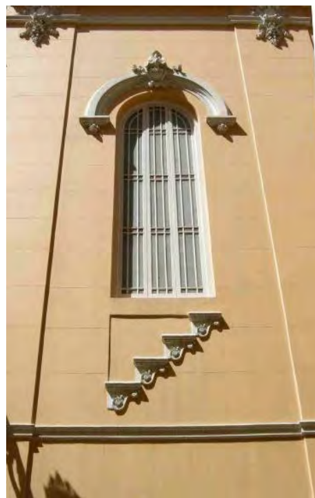
741. Vano del hueco de escaleras.
