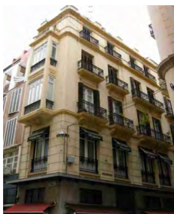
238. Vista de las dos fachadas del edificio de calle Salvago n°4.
