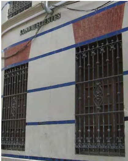
886. En el testero plano, franjas de cerámica alineadas y sobredinteles de ladrillo.
