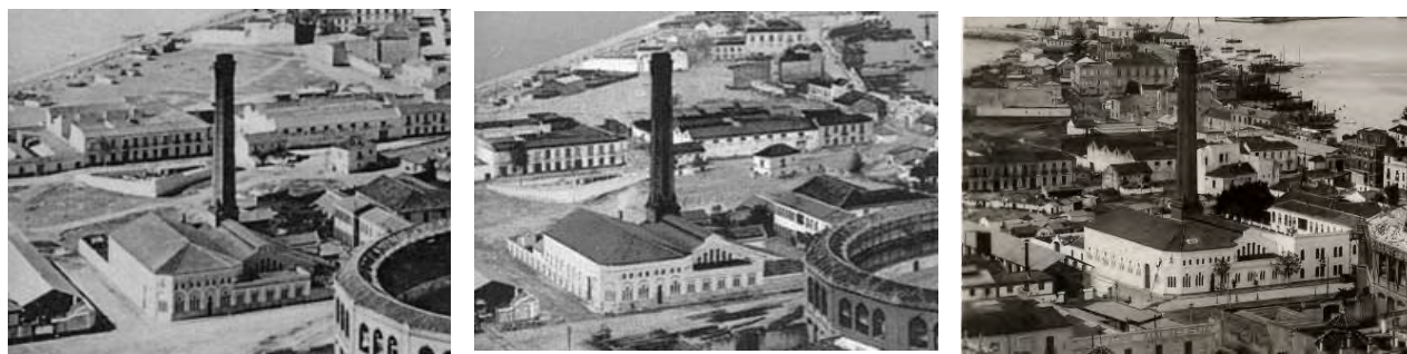
169. Tres imágenes sucesivas en el tiempo de la fábrica de electricidad. Entre las dos de la izquierda hay una diferencia en el cuerpo de la calle Leovigildo Caballero, que se encuentra más regularizado, puede que por la intervención de 1903. En la foto de la derecha ya ha intervenido Brotons, pero no parece que haya cambiado el cuerpo anteriormente citado.
