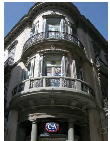
383. Cubillo con balcón volado. En la esquina de las calles Liborio García y Mesón de Vélez.
