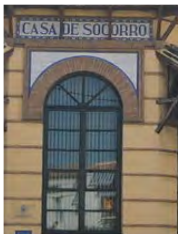
810. Vano del cuerpo exagonal, Arco inserto en álfiz de ladrillo y albanega revestida de cerámica.
