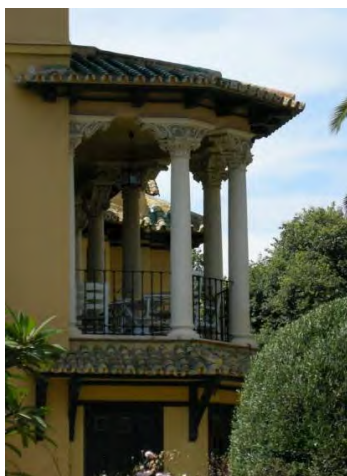
803. Terraza sobre cuerpo añadido a la fachada este. Vista desde el sur.
