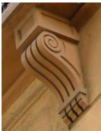
1008. Grandes ménsulas acanaladas bajo los balcones.
