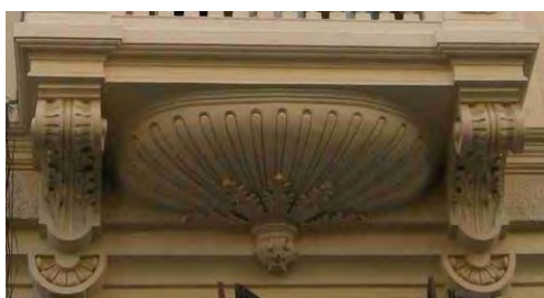
629. Peana bajo mirador en el edificio de Especerías I. G. Strachan 1909.
