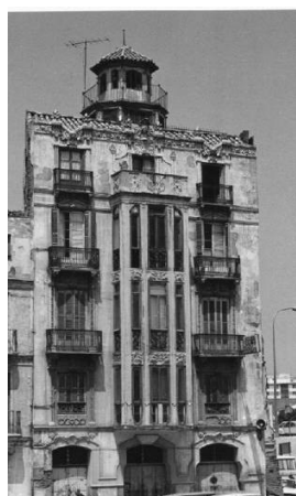
1051. La misma fachada poco antes de su demolición.
