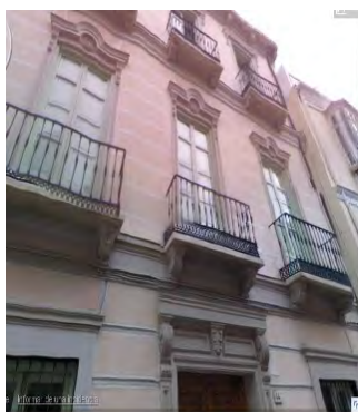
987. Fachada. Madre de Dios 44.
