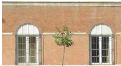
905. Fachada del Asilo de las Hermanitas de los Pobres. Detalle.
