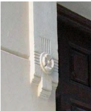
659. Edificio en García Briz 9 y 11. Detalle de la moldura de la puerta de entrada.
