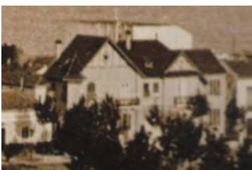
444. Vista oeste de la casa construida por G. Strachan (1911) en la Malagueta.
