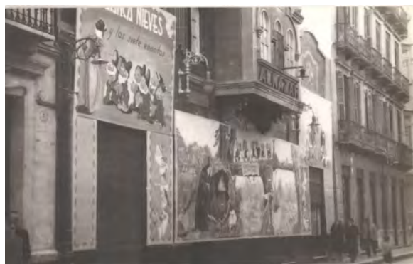
523. De izquierda a derecha los edificios nº 12, 10 y 8-6, antiguos.
