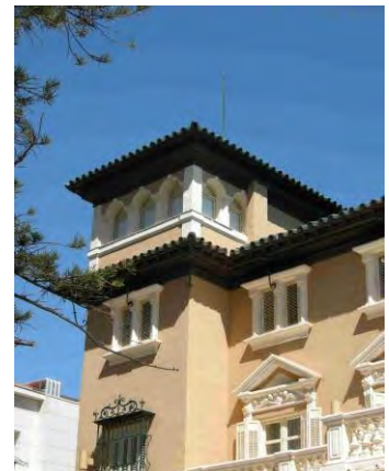
796. Vista de la torre desde la fachada sur.
