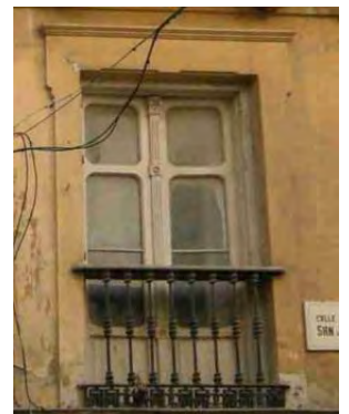
378. Detalle del recercado de hueco
