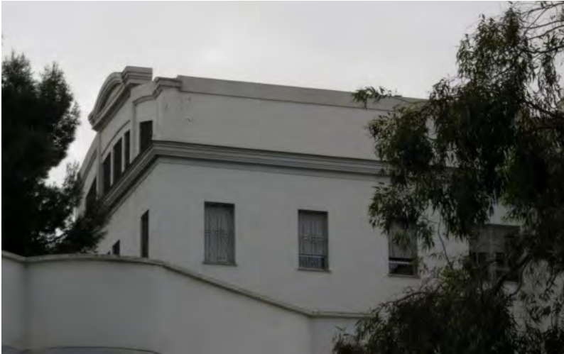
28. Vista actual del encuentro de las fachadas norte y oeste del edificio de Aldama.
