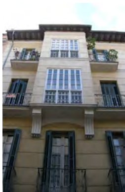
1003. Marqués de Guadiaro 8. Fachada a Álamos.
