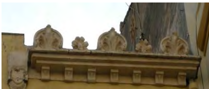
667. Detalle del remate de la cornisa.
