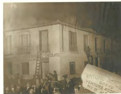
55. Foto del incendio del edificio de Mancilla. 1911.
