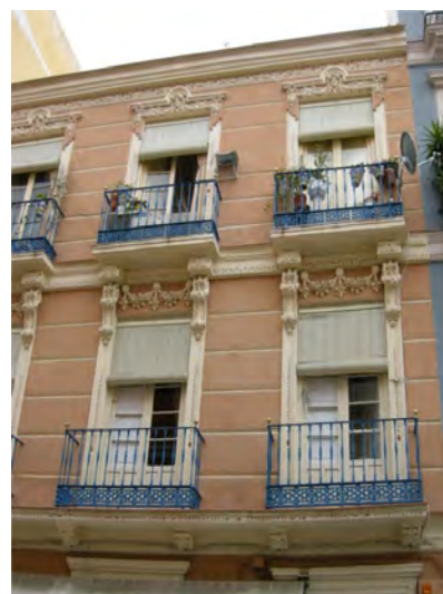
757. Ancha del Carmen 57. Las caras femeninas se sitúan en el piso segundo, y en el primero se decoran los sobredinteles con voluminosas guirnaldas.
