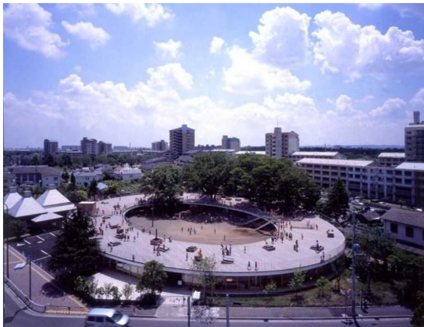
Figura 2. Vista general de la guardería Fuji.
