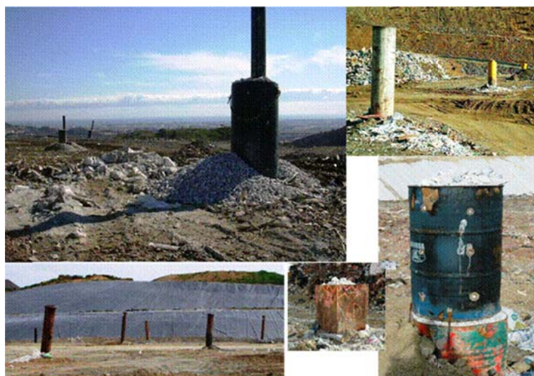
Figura 1.16. Diferentes tipos de pozos/chimeneas de venteo
