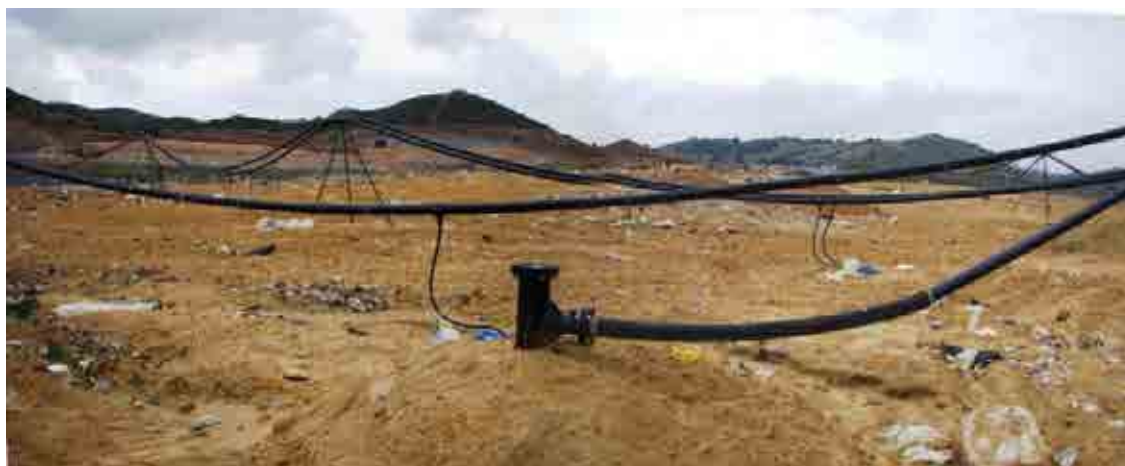
Figura 4.1. Aspecto del campo de gas de V4, en primer término sondeo de desgasificación y conducciones hacia la estación de regulación, se observan los medios adoptadas para la purga de agua colocada en la comba de las canalizaciones.
