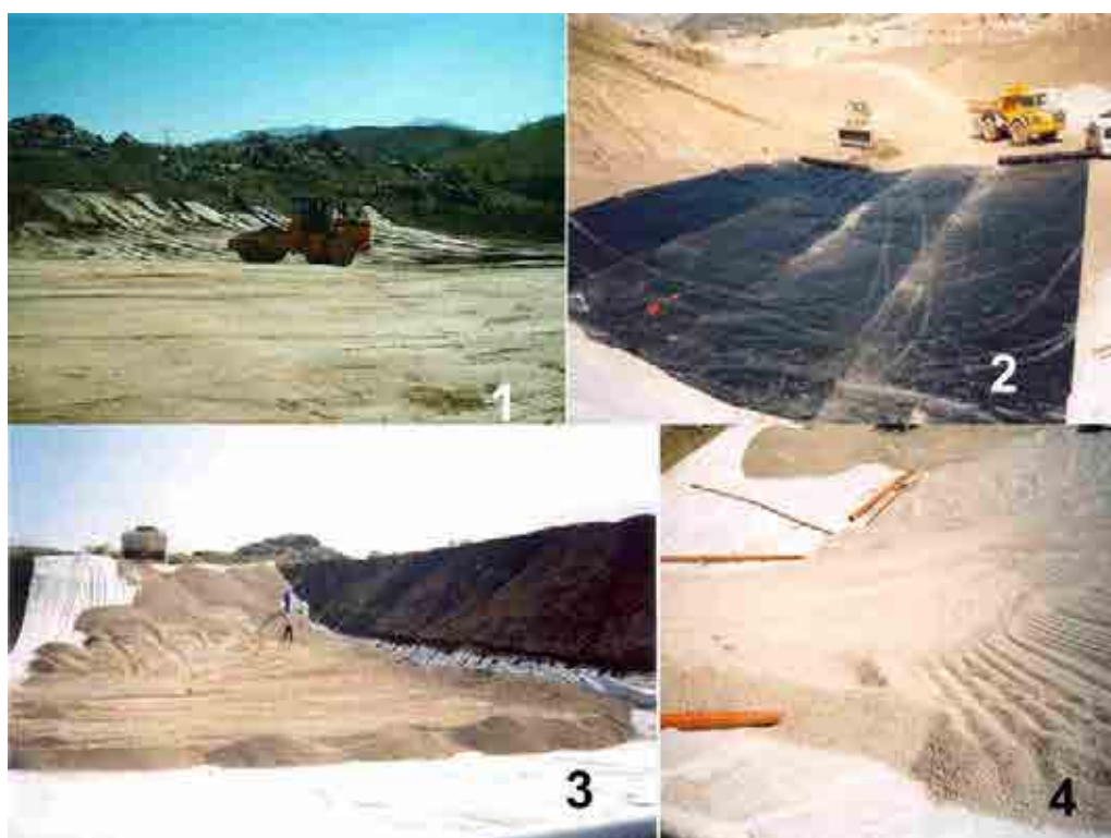
Figura 3.2. 1. Compactación del terreno tras la nivelación. 2. Extendido de geomembrana sobre geotextil. 3. Colocación de la capa de drenaje (grava) sobre geotextil. 4. Replanteo de la red de drenaje en la capa homónima.
