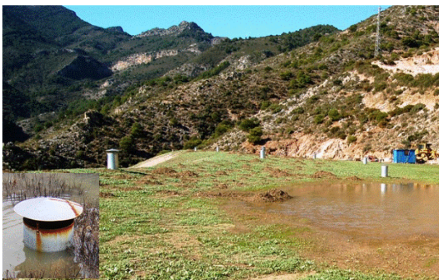
Figura 1.15. Chimeneas de desgasificación (pozos de venteo) en vertedero sellado.
