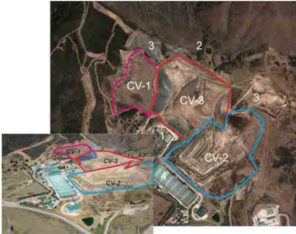
Figura 1.5. Perspectiva de las instalaciones del Complejo Medio Ambiental de la Costa del Sol. CV-1 Vaso de vertido 1, CV-2 Vaso de vertido 2, CV-3 Vaso de vertido 3, 1- Depósitos de lixiviados, 2- Balsa de agua, 3- Zonas de préstamo, 4-Instalaciones
