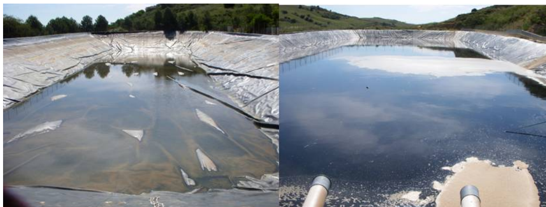
Figura 6.20. Las dos balsas de Casarabonela, una en periodo de mantenimiento y otra en explotación.
