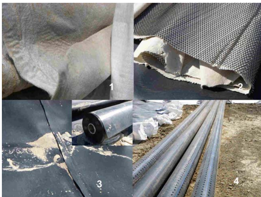
Figura 3.3.-1- Geotextil de 800 gr/m 2 , 2-geomalla formada por lámina de polietileno entre dos geotextiles de 120 gr/m 2 , 3- Solape entre dos láminas de PEAD de 2 mm, se aprecia la soldadura térmica, 4- tubos de drenaje para el fondo del vaso.
