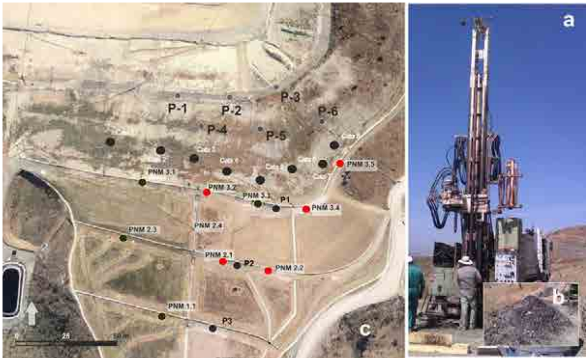
Figura 5.16. a - Ejecución de piezómetros para drenar lixiviado a cota 200 en V2L, b- aspecto del ripio extraído del sondeo P5s (caucho y metales), c- situación de pozos mixtos, piezómetros y catas en la zona afectada de V1L y V2L. Los círculos rojos corresponden al esquema de bombeo más habitual.
