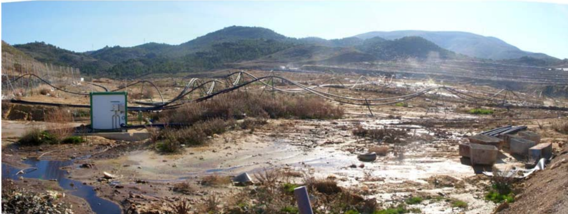
Figura 4.2. Panorámica desde la esquina noreste del vertedero (V4). Se aprecian las estaciones de regulación y mantenimiento del campo de gas así como los sondeos y otras instalaciones para el aprovechamiento del biogás. En la zona este se aprecia el depósito de compost y lodos utilizado en la cobertura así como el encharcamiento ocasional producido por la aspersión.
