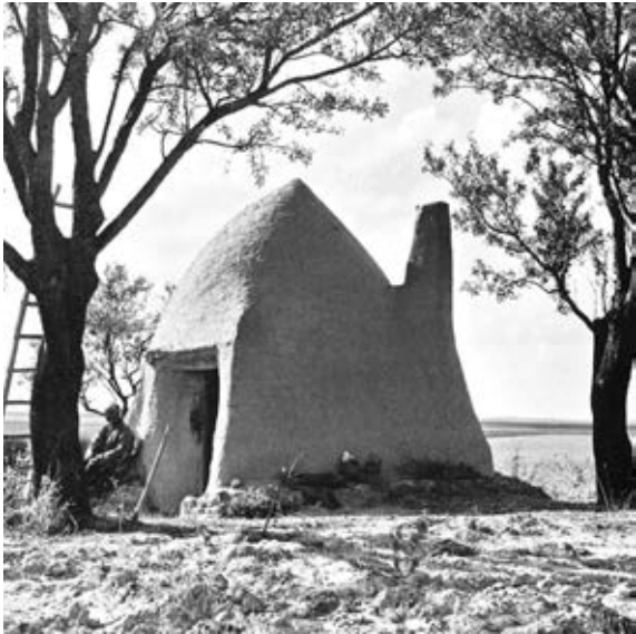
5-II. Refugios de pastores en la cuenca del río Esla. Para explicar el aparejo de estos refugios Asís Cabrero utiliza fotografías en las que se muestra completo y un dibujo del nudo de encuentro entre las diferentes partes. C.L.
