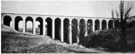
35-I. Viaducto de los Quince Ojos. Eduardo Torroja. 1933.
