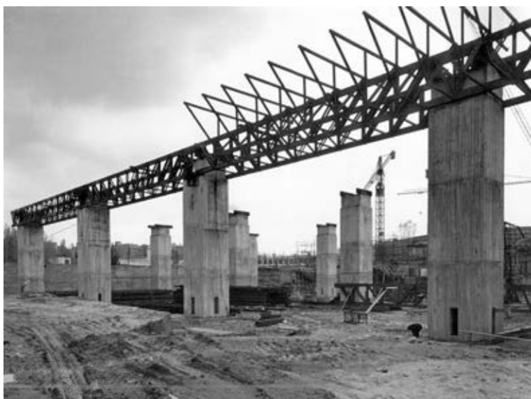
139-IV y 140-IV. Del pórtico seriado a la retícula. Para conseguir el vuelo de la planta superior respecto a los pilares de la planta baja en la fachada oeste, los autores realizan una estructura triangulada que vuela desde la última viga puente. También con una clara voluntad formal, la cubierta se inclina hacia el interior en contacto con la fachada oeste consiguiendo un perfil plano para la cornisa del pabellón.
