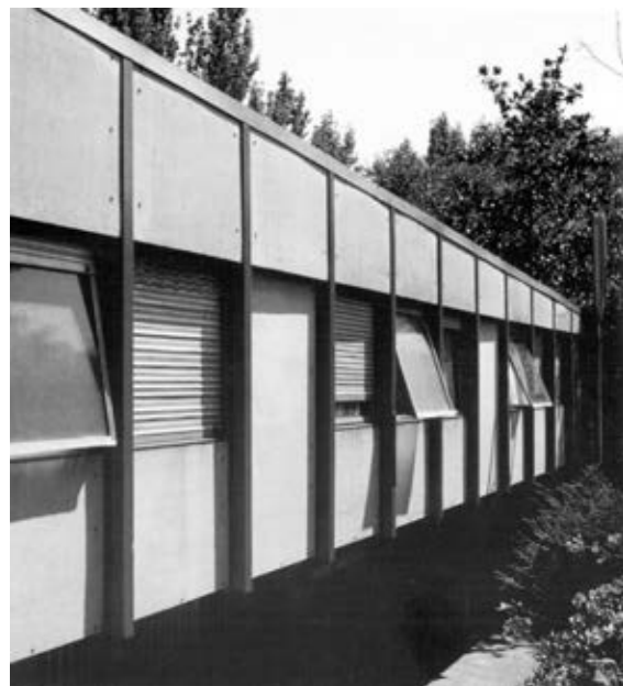
202-IV y 203-IV. La expresión útil del aparejo. Tanto en el ala de los salones, donde la estructura sobresale de la casa conformando el porche, como en el compacto volumen de los dormitorios, el aparejo muestra la expresión útil al exterior.
