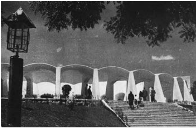
53-II. La Plaza de acceso. Vista desde el exterior.
