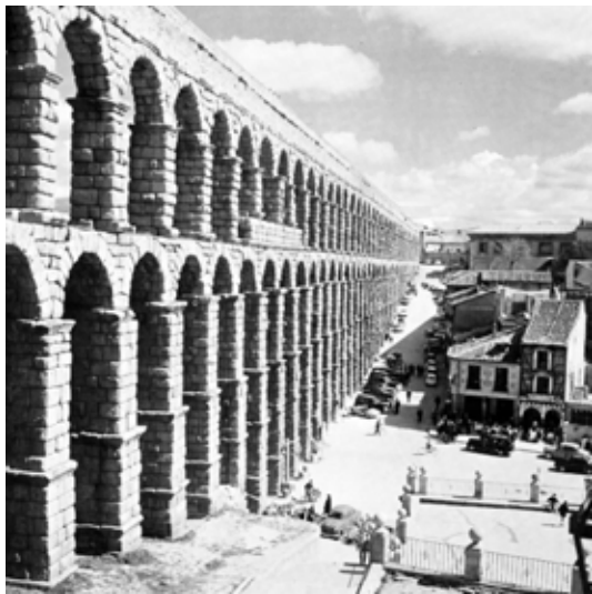
36-I. Acueducto de Segovia. Fotografía de Asís Cabrero. Una estructura que una vez amortizada su utilidad, se ha convertido en un monumento. C.L.
