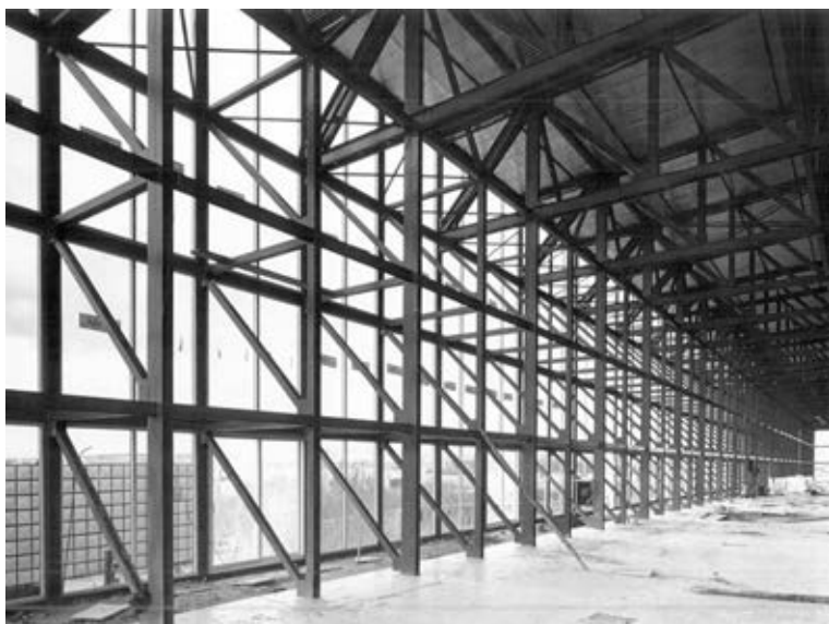
137-IV y 138-IV. Del pórtico seriado a la retícula. Para hacer compatible la seriación de pórticos paralelos de la planta superior con la estructura en retícula de pilonas retranqueada de fachada, los autores construyen una viga de borde que recogerá las cargas de la estructura para trasmitirla a los pilares mediante seis vigas dobles.
