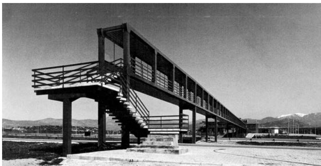
235-IV. La pasarela. Asís Cabrero construye la pasarela de la estación de servicios a través de una doble viga Vierendeel como si del puente de la cruz de Cuelgamuros se tratara y la pinta de naranja con la intención de trasladarla al fondo de "las lejanas veladuras" .
