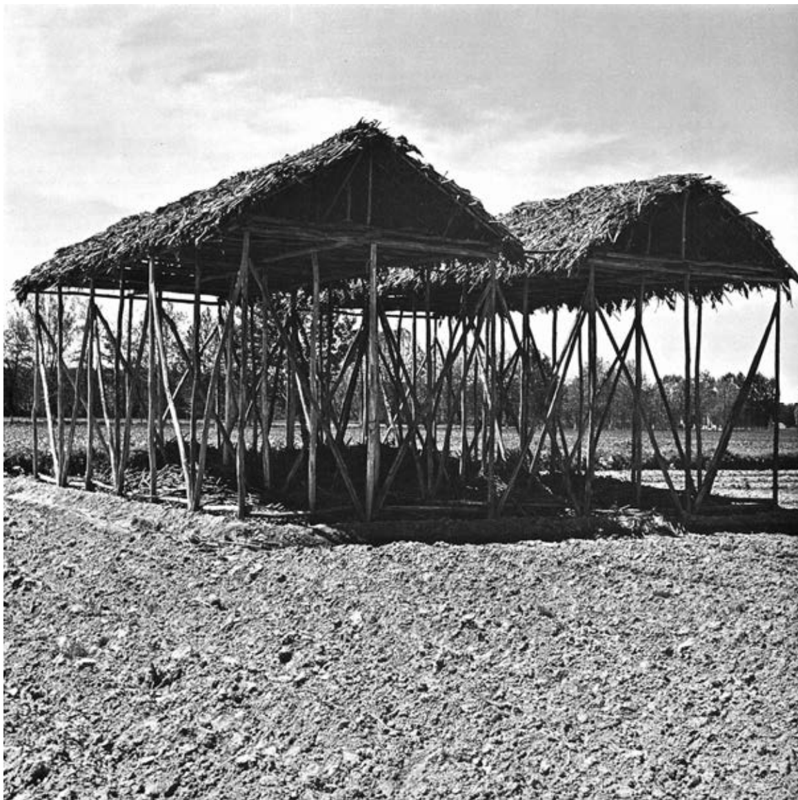
1-IV. El entramado. Fotografía que Asís Cabrero utiliza para ilustrar el capítulo dedicado al entramado en el cual explica que este aparejo surge de las capacidades resistentes y de factura de la madera. C.L.
