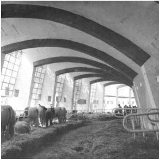
83-II. Pabellón de la maquinaria transformado posteriormente en pabellón para el ganado. A.A.C.
