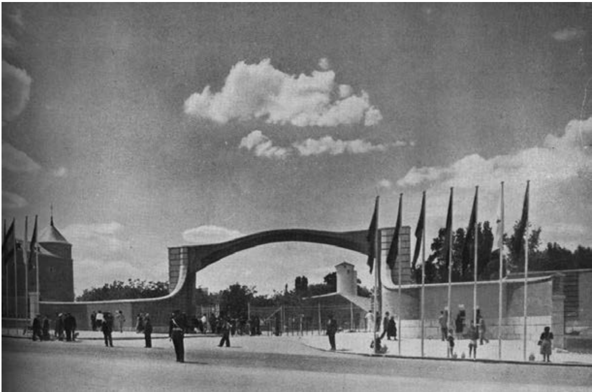
48-II. La puerta de acceso. Aunque fuera del recinto estudiado y pese a que Asís Cabrero no la incluye en sus publicaciones sobre la Feriá del Campo , destacamos de esta puerta el uso del ladrillo aparejado en forma de muros curvos, y el arco de hormigón armado curiosamente forrado de ladrillo. Estos aparejos anuncian la arquitectura que los autores desarrollan en el recinto.
