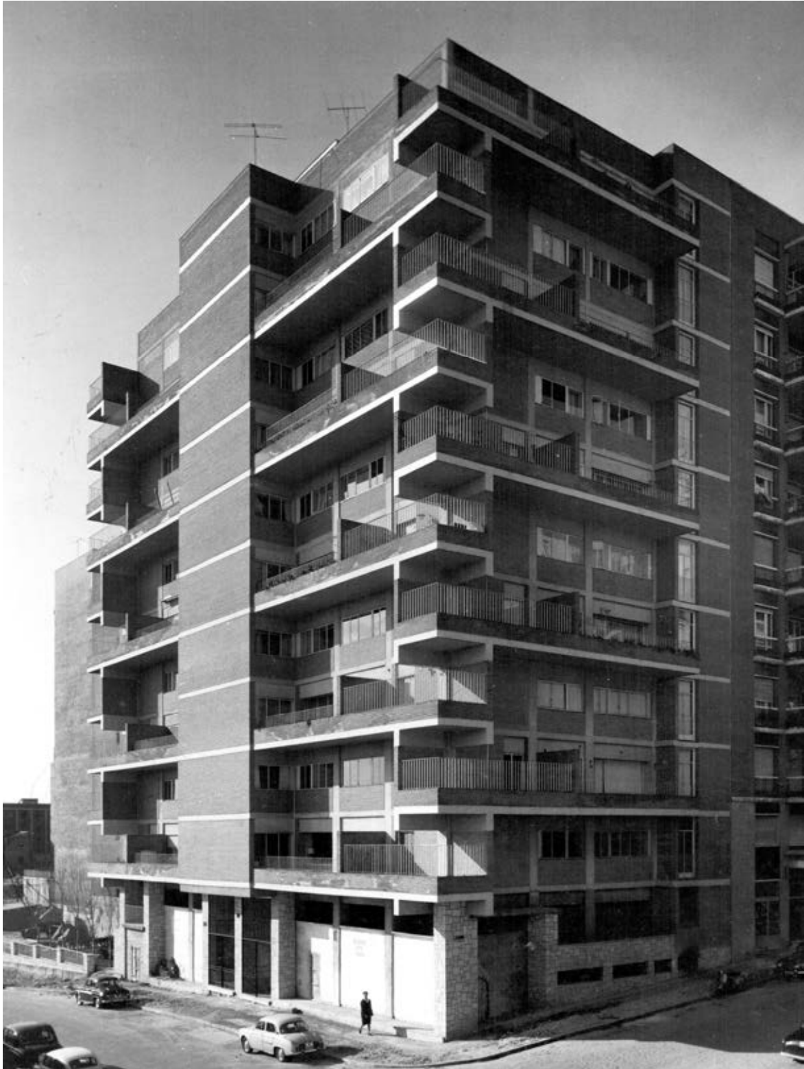
22-III. Casa en calle Reyes Magos. Madrid. 1956. Asís Cabrero muestra en escorzo el bloque de viviendas en calle Reyes Magos. Esta vez los testeros permanecerán abiertos y mostrará en las esquinas el cruce de las jácenas voladas de hormigón armado. A.A.C.
