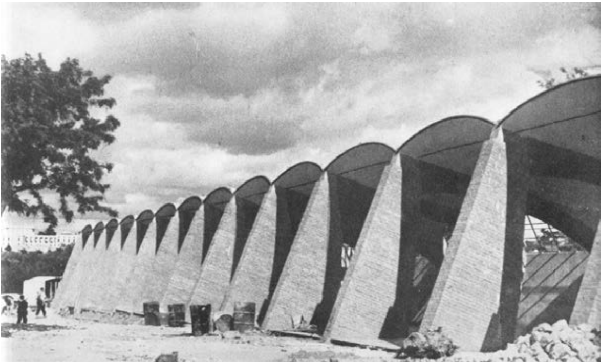
76-II. Pabellón nº3 de los productos agronómicos. Fotografía de obra.
