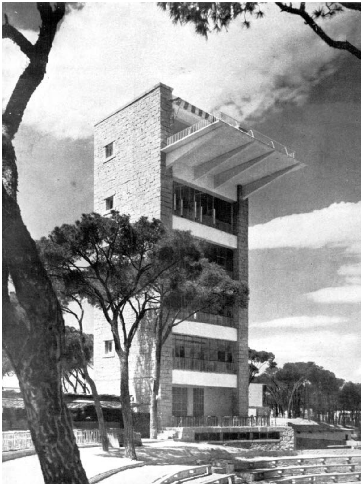
1-III. La torre mirador del restaurante de la I Feria del Campo. Fotografía de Alberto Ferriz en la que se aprecia el pabellón aún en construcción.
