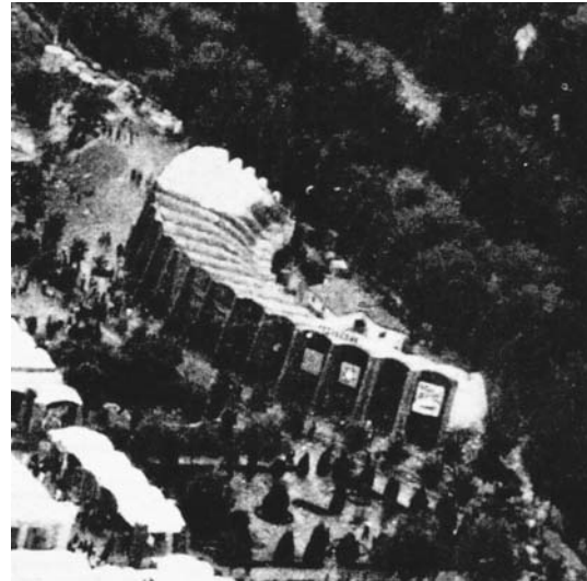
84-II. Cara y espalda. Vista aérea del Pabellón de la maquinaria agrícola aún en construcción.
