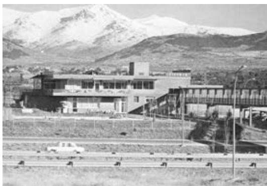
234-IV. El edificio. El autor proyecta el edificio del restaurante con un ladrillo de un color similar al del fondo con la intención de fundirlo en el paisaje.
