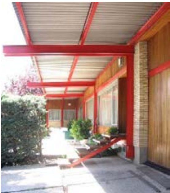
202-IV y 203-IV. La expresión útil del aparejo. Tanto en el ala de los salones, donde la estructura sobresale de la casa conformando el porche, como en el compacto volumen de los dormitorios, el aparejo muestra la expresión útil al exterior.
