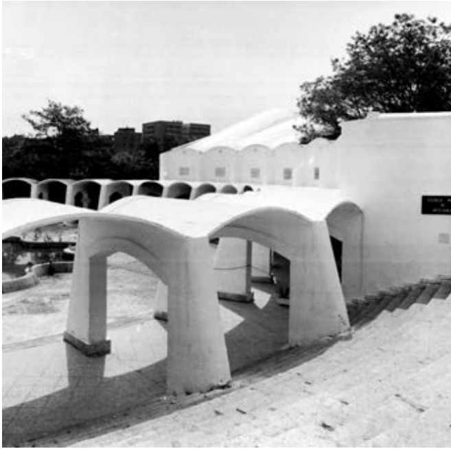
58-II. Plaza de acceso. Escalinata de acceso al zoco. A.A.C.
