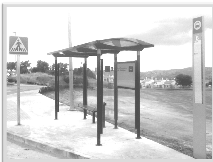
FIGURA 8.- Fotografía de marquesina junto a poste de parada
