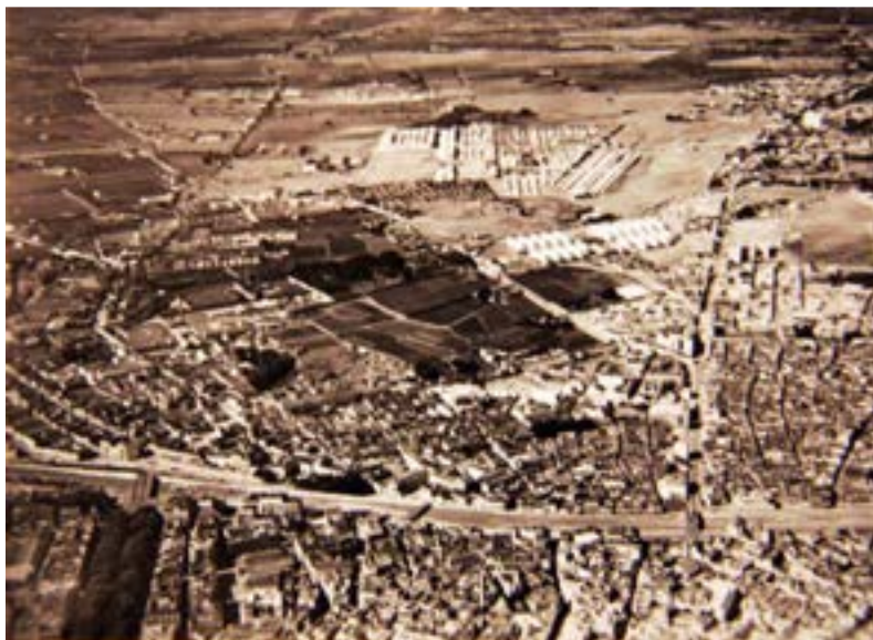
299: Vista aérea de la zona oeste de la ciudad de Málaga. Se aprecia aún los barrios históricos de El Perchel y de Santo Domingo (aunque se han comenzado las demoliciones), las huertas y la barriada de Carranque , con parte del segundo tramo de la Prolongación ya proyectado, s. f. (AHPM).
