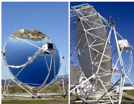
Figura 2.13: Disco Stirling. Proyecto EuroDISH, motor SOLO V161, 10 kW. Fuente: (PSA)
