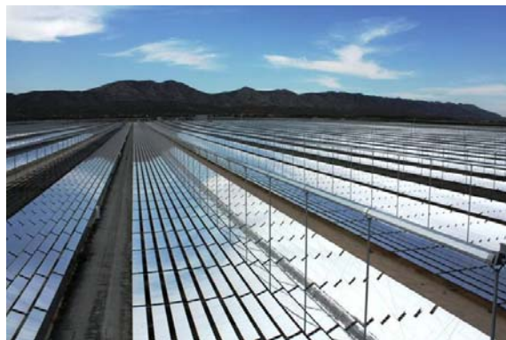
Figura 2.11: Puerto Errado 2, Central Termosolar Lineal Fresnel de 30 MW en Calasparra (Murcia).
