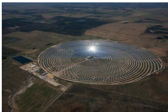
Figura 2.12: Vista aérea de la Central Gemasolar, 19,9 MW.
