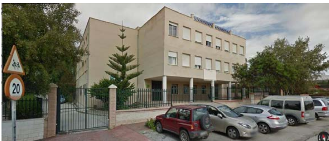
Imagen 106: Fachada principal del instituto
