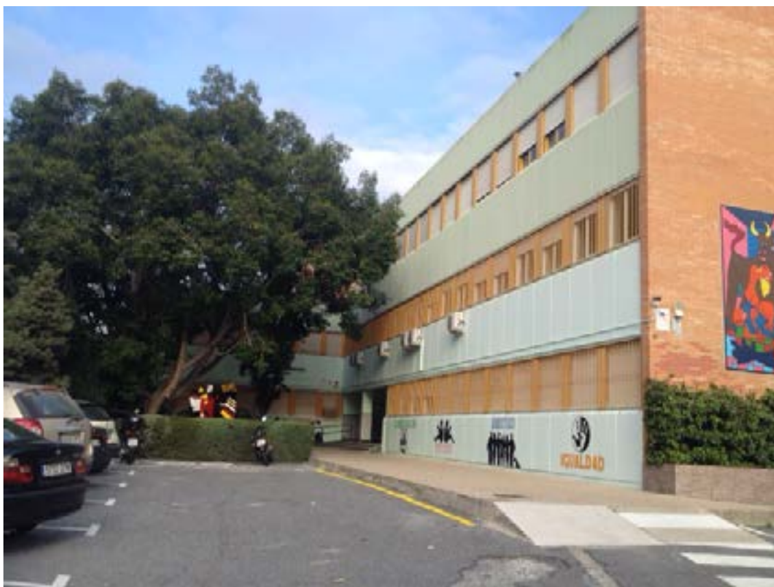
Imagen 93: Entrada del instituto Pablo Picasso de Málaga
