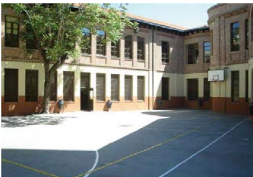
Imagen 27: Edificio del grupo escolar Cervantes proyectado por Antonio Flórez en 1913.
