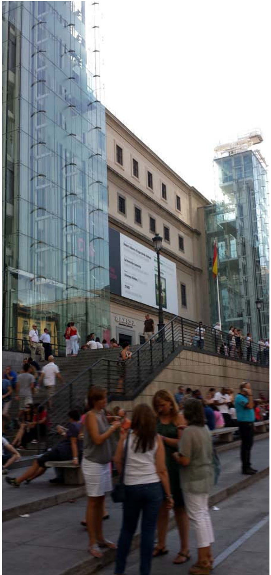
11 Íñiguez de Onzoño y Vázquez de Castro. Imagen exterior de las torres de comunicación vertical en la actualidad.
