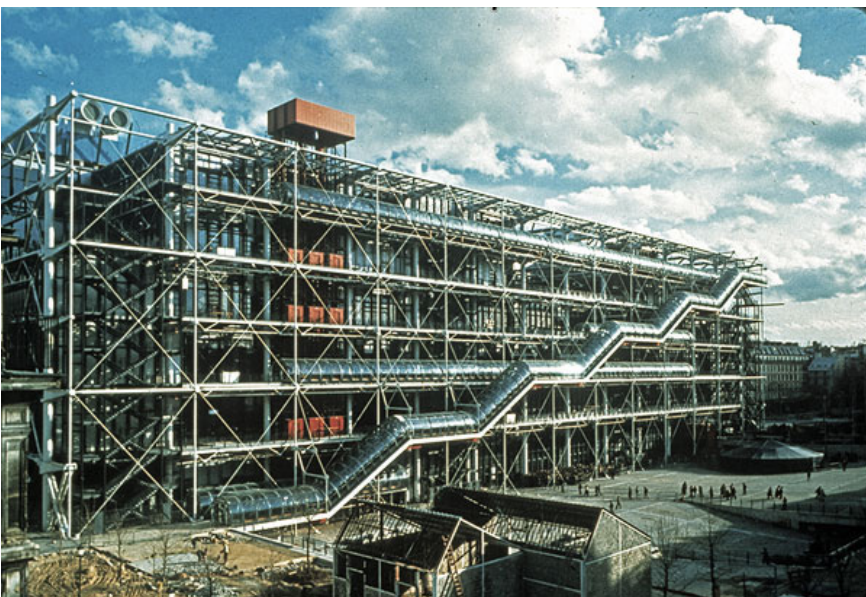
05 Richard Rogers y Renzo Piano. Imagen de la excavación de la parcela del Centro Pompidou.
