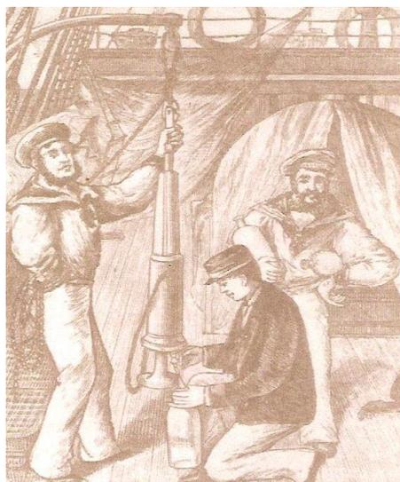
**Figura 1.4** Un científico toma muestras de agua a bordo del "Challenger", (1872-76) con el instrumento concebido por J.Y. Buchanan, el químico de la expedición (Kirwan 1965).
