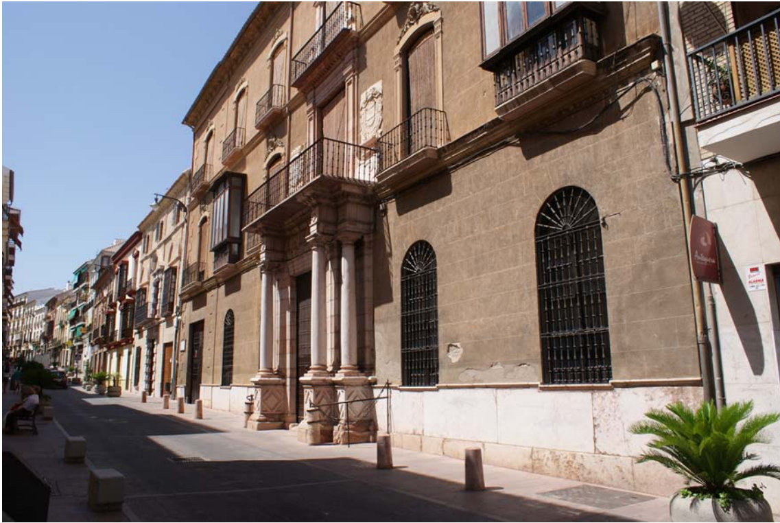
Imagen 6: Vista general de la fachada del palacio.
