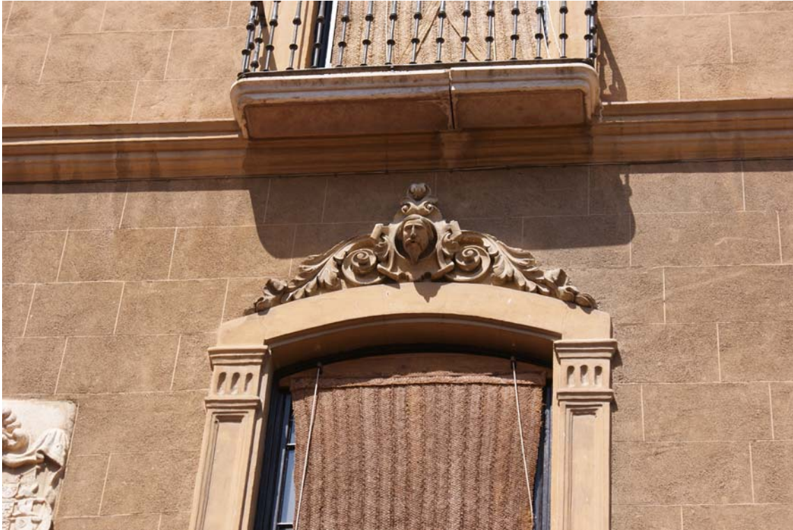
Imagen 2: Detalle del balcón en la fachada principal del palacio.
