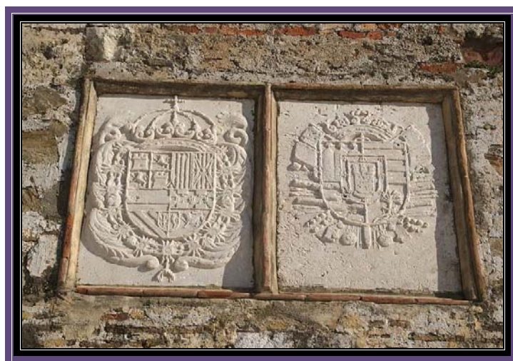
Ilustración 2: Escudos sobre la puerta del hornabeque del Frente de la “Valenciana”, en la fachada de la Plaza de Armas
