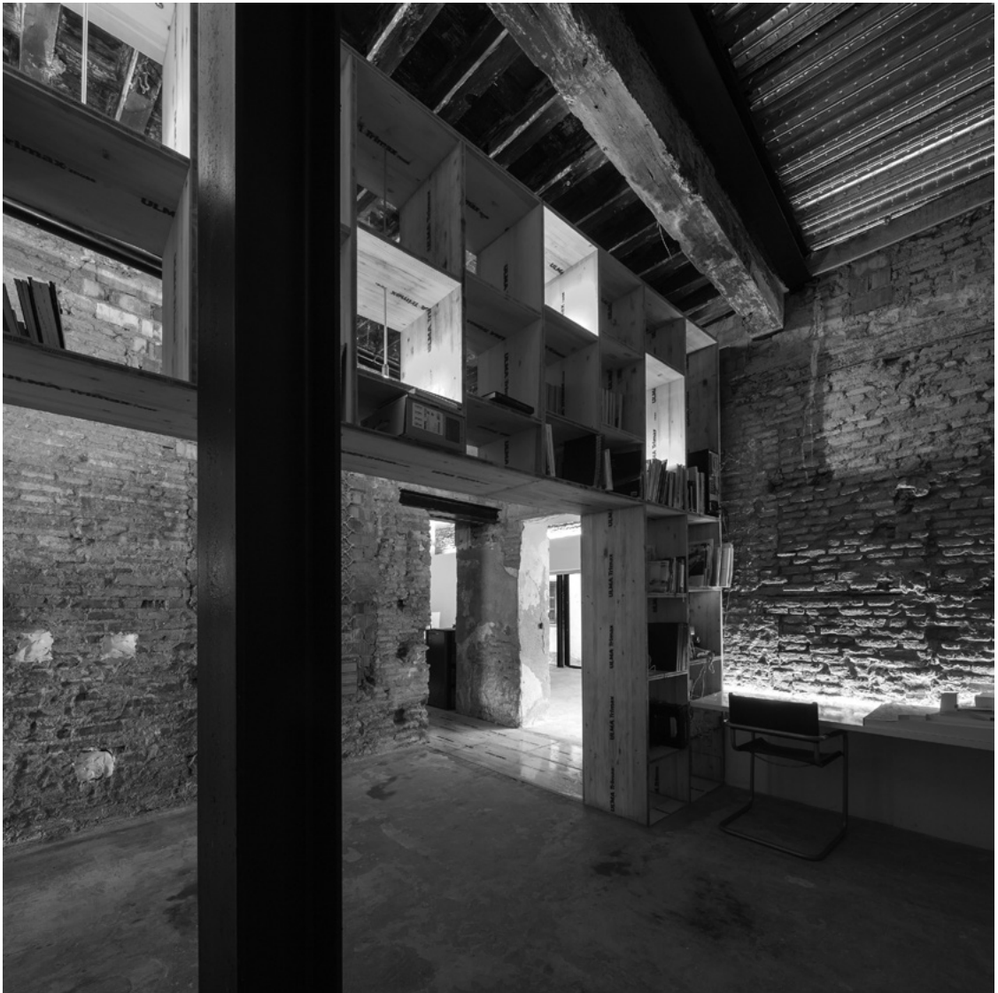
Fragmento del mueble-infraestructura realizado con tableros de encofrado de madera reutilizados, colgado en primer plano y apoyado para canalizar las instalaciones de red. Fotografía: Fernando Alda, 2015
