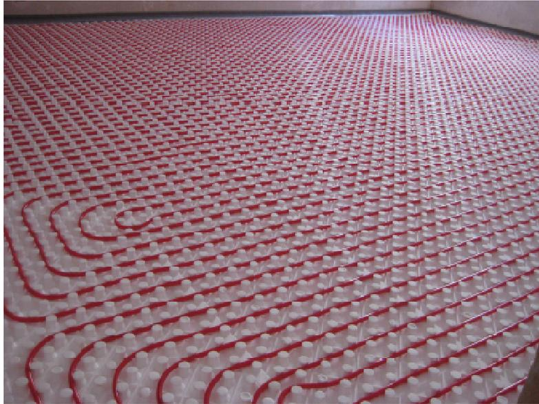
Fig. 1.3. Instalación de suelo radiante.
