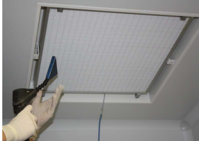
Figura 4. Test de integridad de filtros. Fuente: elaboración propia.
