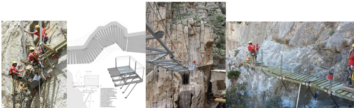
Fig. 8-9-10: Imágenes tomadas durante la ejecución de las obras.
