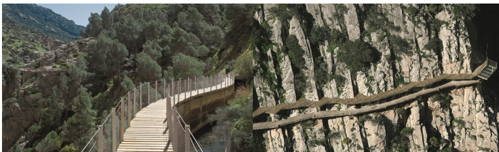
Fig. 14-15: Imágenes tomadas tras la finalización de las obras.
