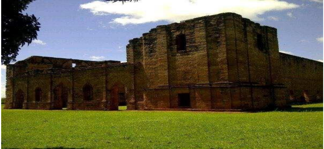
Foto 1. Fachada de la Reducción de Santísima Trinidad
