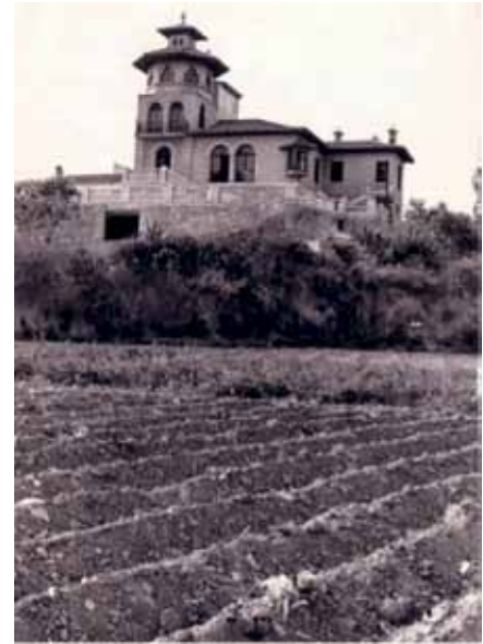
Ilustración 46: Edificio original de La Milagrosa
