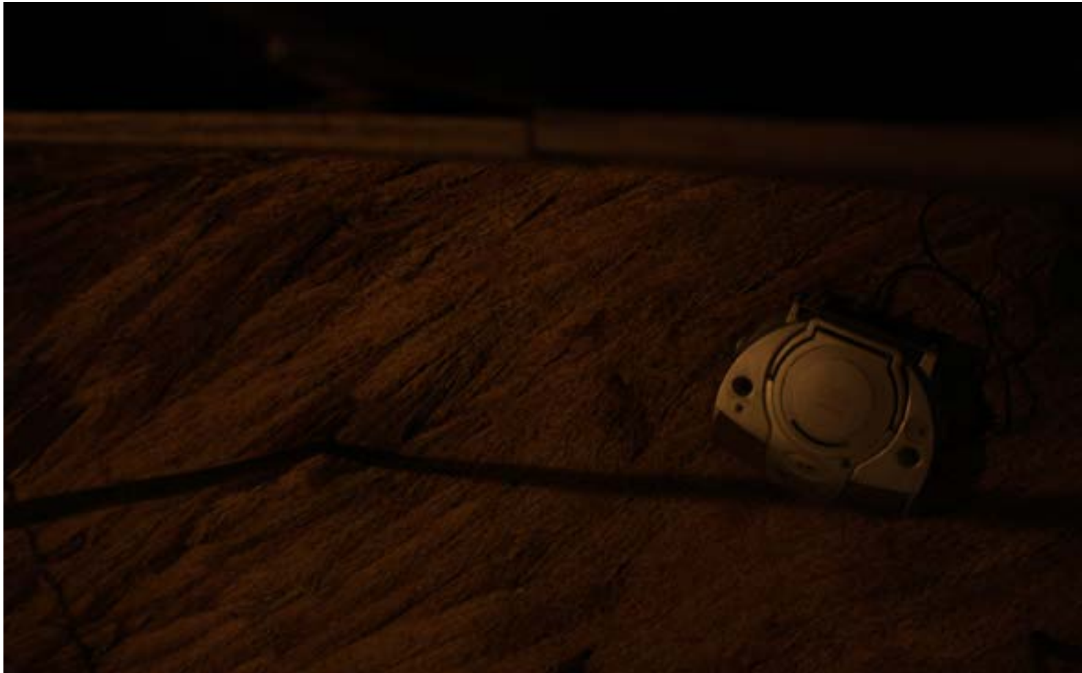
Detalle de la instalación, vista desde la estantería
