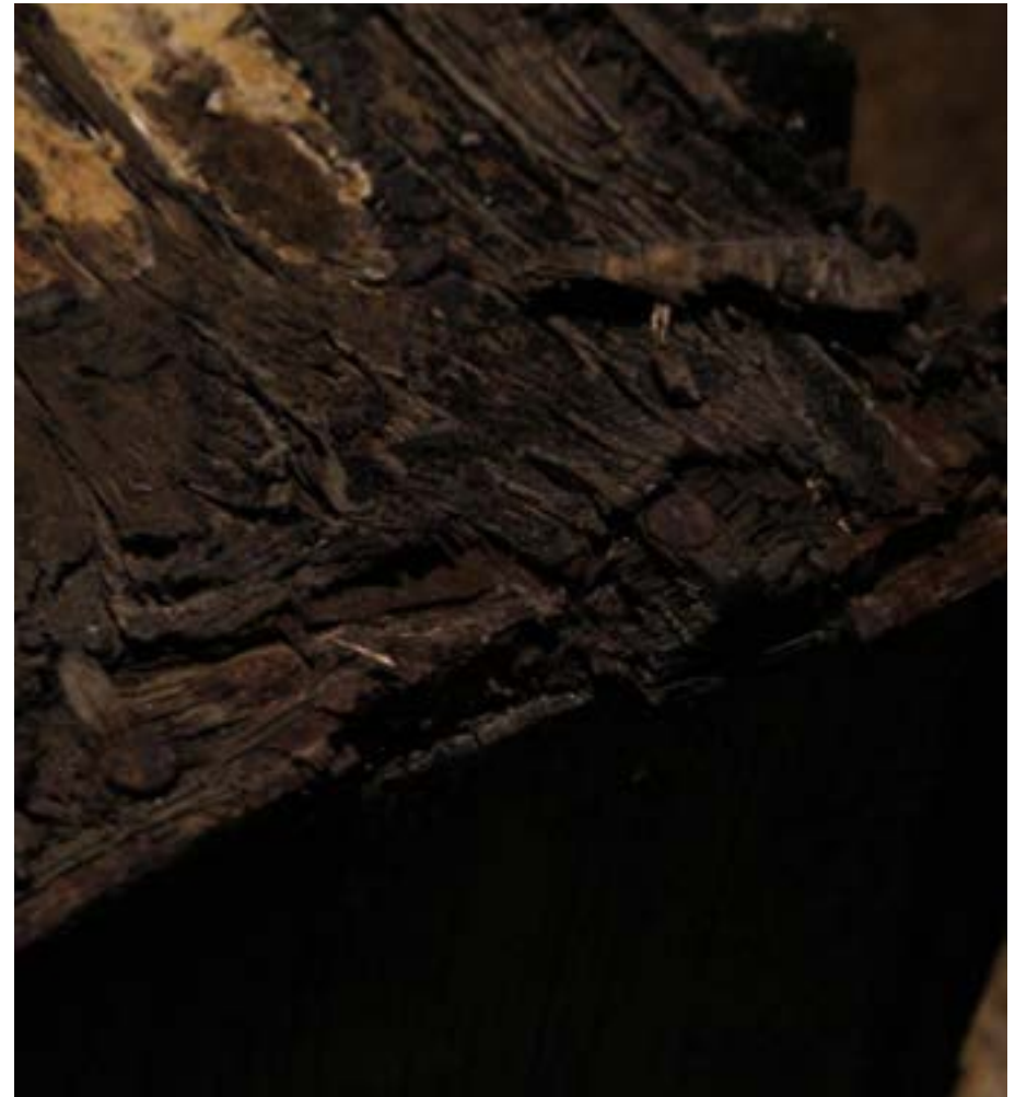
Detalle de los objetos familiares propuestos para la instalación, en los que puee verse el deterioro.
