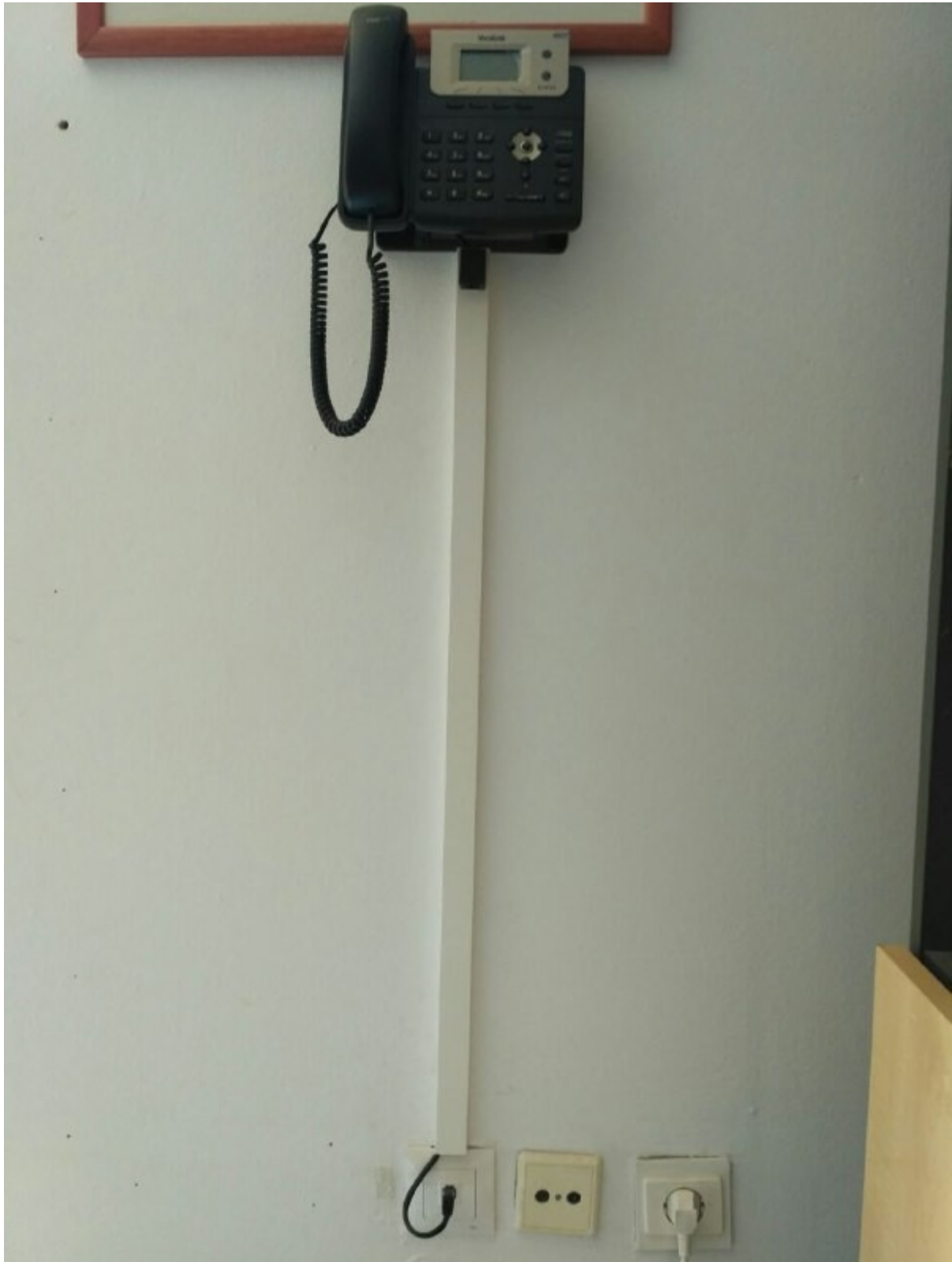
Figura 37: Instalación resultando del teléfono en un apartamento
