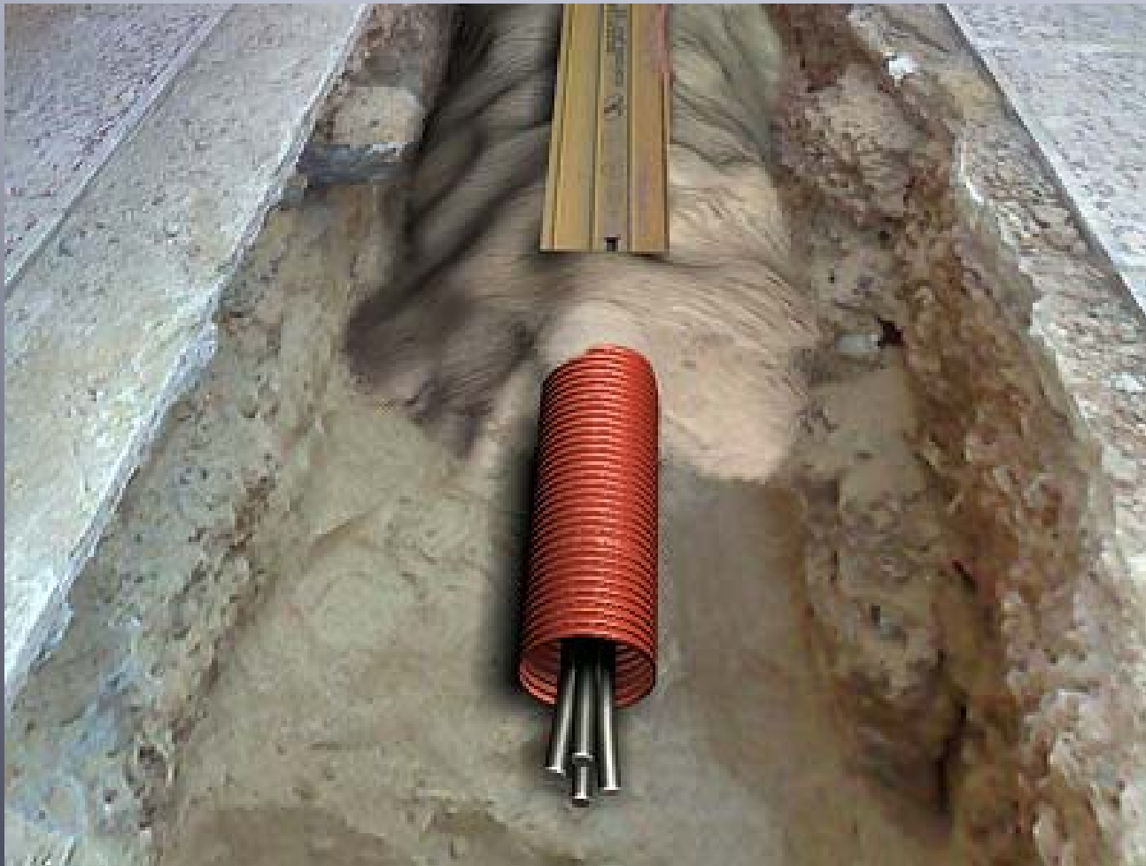
Zanja para instalación eléctrica (Cype Ingenieros, 2018)
