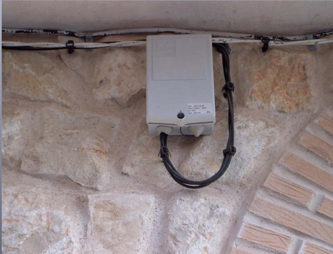
Caja general de protección monofásica instalada sobre fachada de edificio de viviendas
