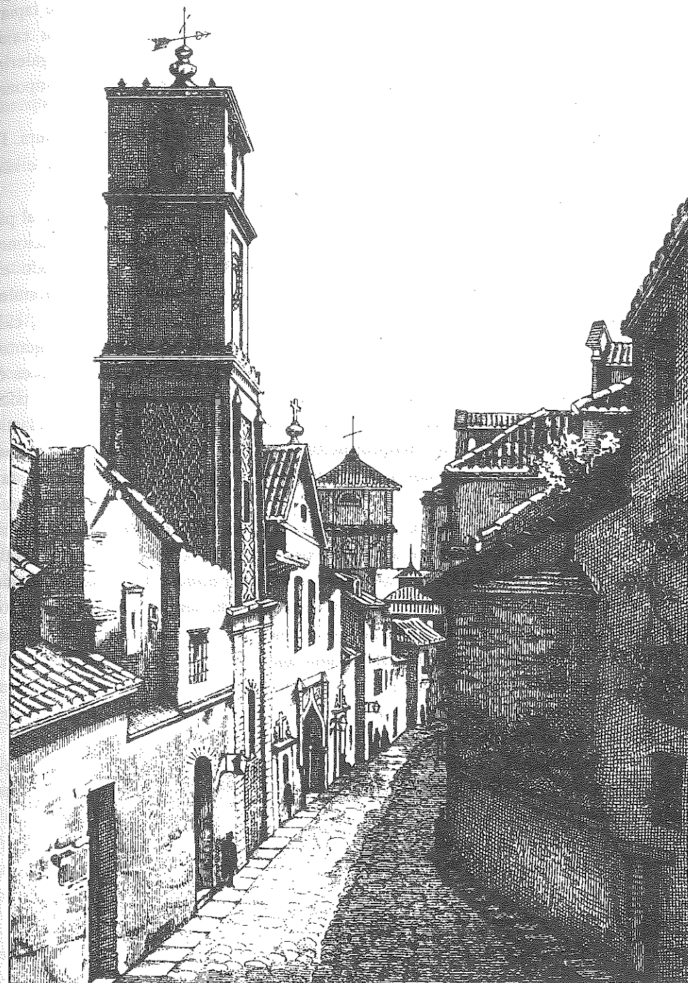
Fig. 29. Torre de la Parroquia de Santiago. 1839.
